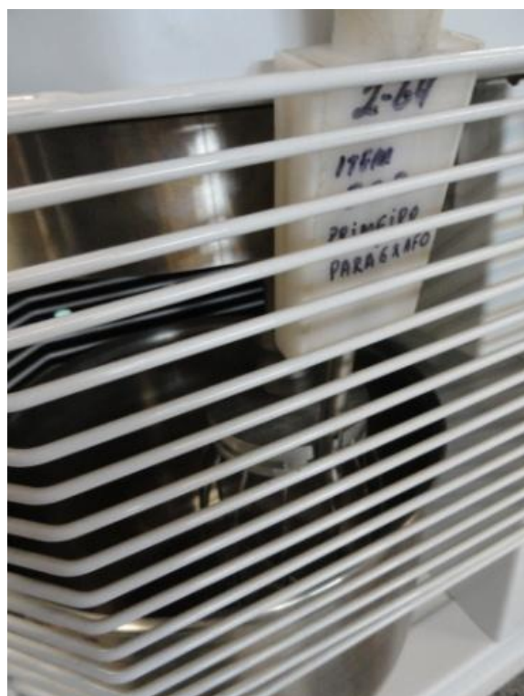
Figura 12 - Acesso ao batedor por cima da grade de proteção.
