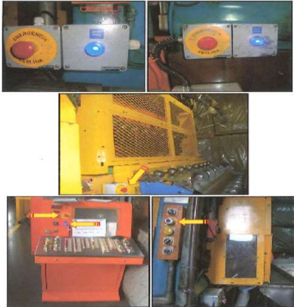
Figura 23 – Botões de parada de emergência e reset da Minster
