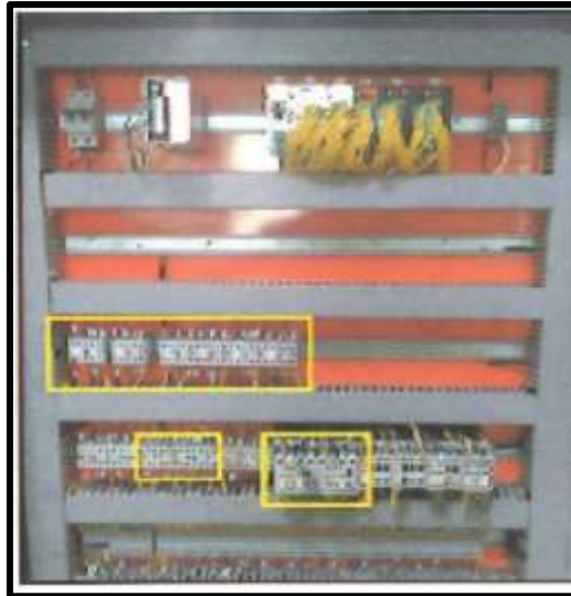
Figura 21 – Contactores de segurança
