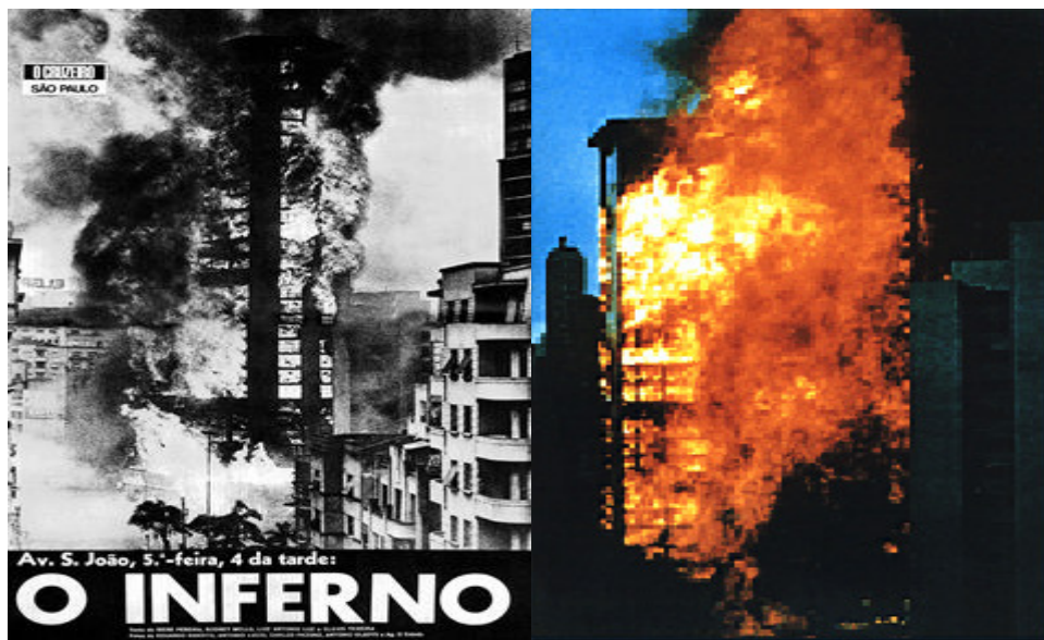
Figura 2: Incêndio no edifício Andraus ocorrido em 1972
