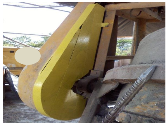
Figura 9: Proteção da Engrenagem Betoneira
