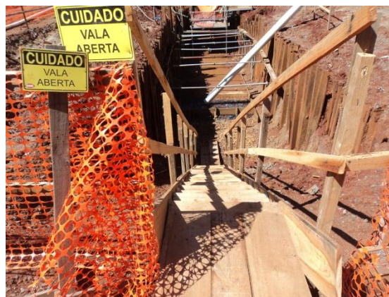
Figura 32: Escada de acesso
