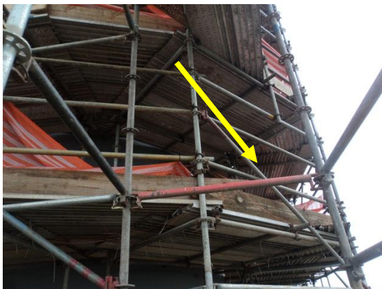
Figura 61: Trabalho em Altura
