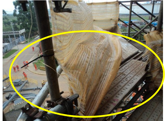
Figura 60: Trabalho em Altura
