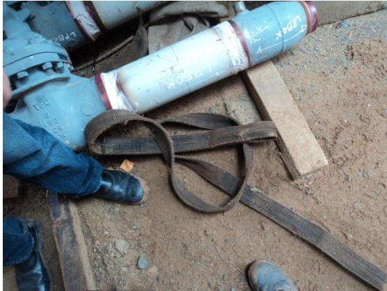
Figura 18: Cintas de Elevação
