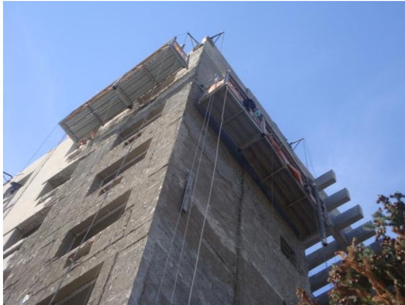
Figura 10 – AndAIMES suspensos mecânico com afastadores.
