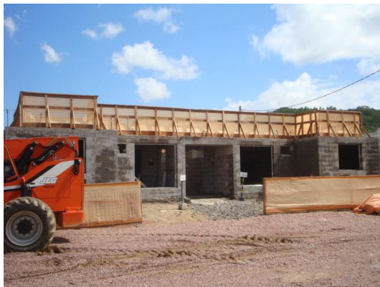
Figura 4 - Laje com proteção de periferia com mão francesa.
