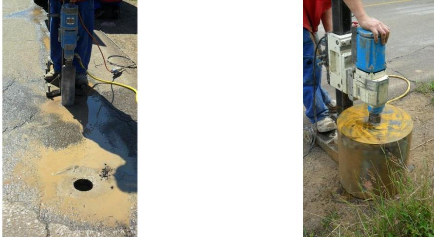
Figura 3.12 - Sondas rotativas utilizadas para extração das amostras do pavimento ( $\varnothing 100$  mm e  $\varnothing 400$  mm)
