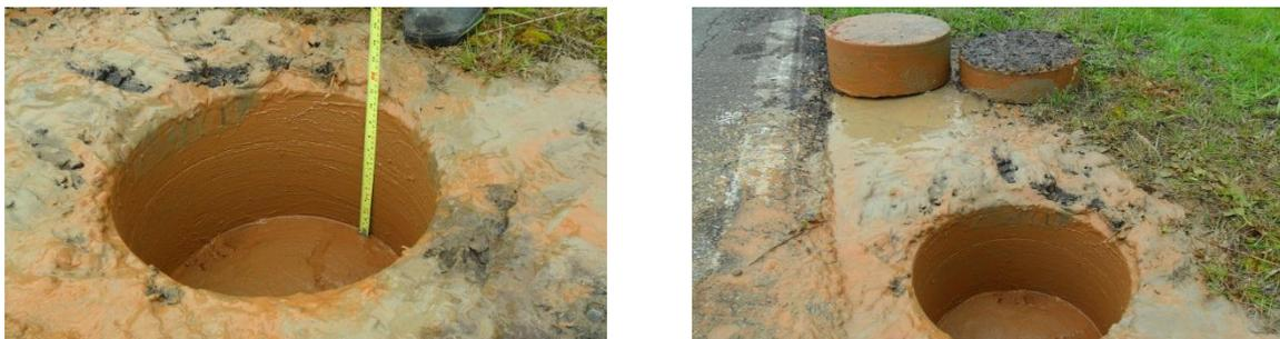
Figura 5.8 – Sondagem no acostamento estaca 2+700.
