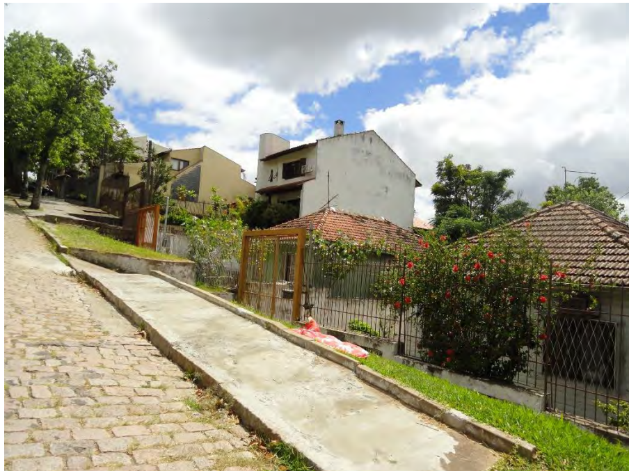
Foto 41: Edificações da rua Upamaroti, bairro Cristal, exemplos de adaptação do relevo à construção, criando patamares entre os lotes na área de morros da área de estudo. Dezembro de 2013.
