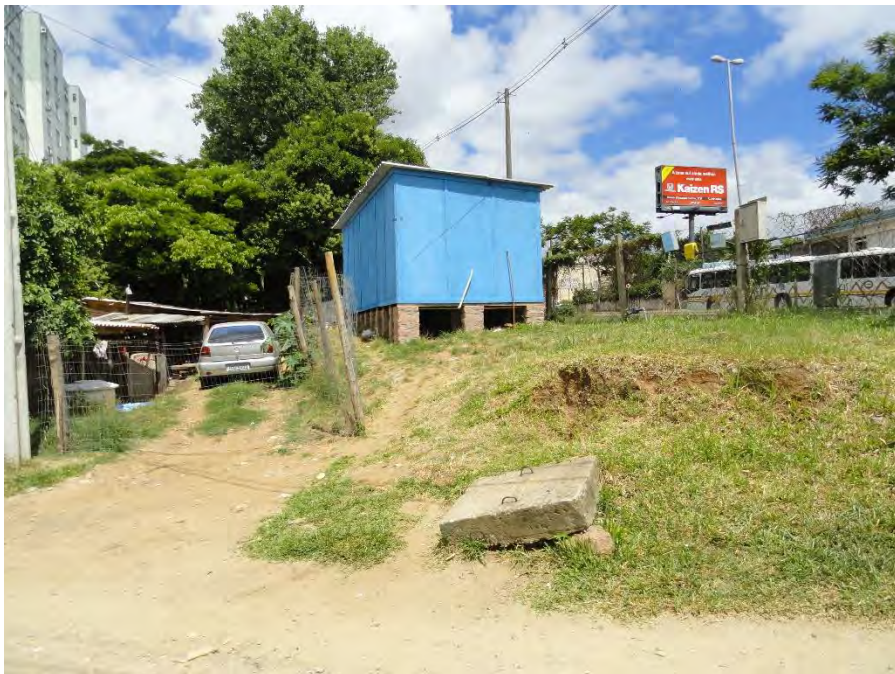
Foto 49: Degrau de corte localizado paralelo à avenida Dr. Campos Velhos, bairro Cavalhada. Dezembro de 2013.
