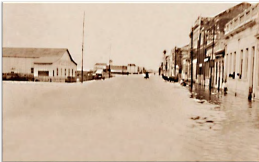
Foto 5: Trecho da Rua Voluntários da Pátria totalmente coberto pelas águas, em 1928. Fonte: Porto Alegre: uma história fotográfica, 2013.
