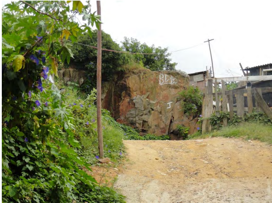
Foto 42: Cicatriz de mineração localizada da área de estudo, ao norte da bacia hidrográfica junto ao compartimento de morros com ocupação irregular, bairro Cristal. Dezembro de 2013
