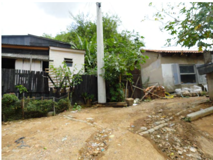
Foto 45: Via localizada em um loteamento ao norte da sub-bacia hidrográfica, no compartimento de morros, bairro Cristal. Evidencia-se a concentração dos fluxos no escoamento superficial, com processo erosivo formando sulco. Dezembro de 2013.
