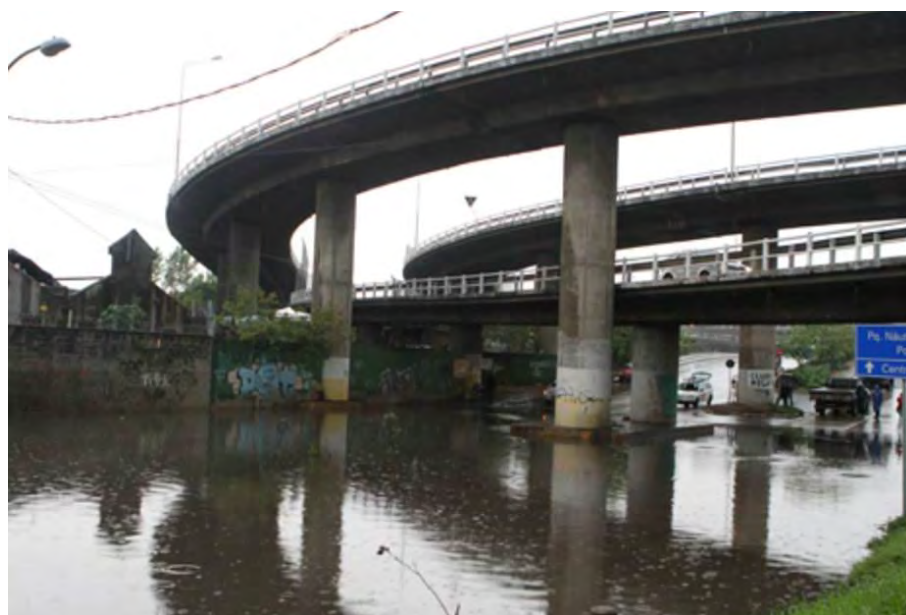
Foto 8: Alagamento registrado no cruzamento da Av. Sertório com Av. Voluntários da Pátria, bairro Marcílio Dias, sob as alças de acesso à ponte do lago Guaíba no dia 18 de setembro de 2012. Fonte: Jornal do Comércio, 2013.
