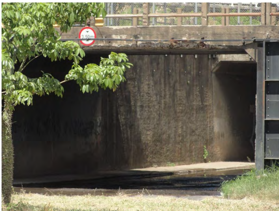
Foto 38: Portão de ferro abaixo da avenida Castelo Branco para ser fechado em caso de cheia do lago Guaíba. Bairro Marçílio Dias. Dezembro de 2013.
