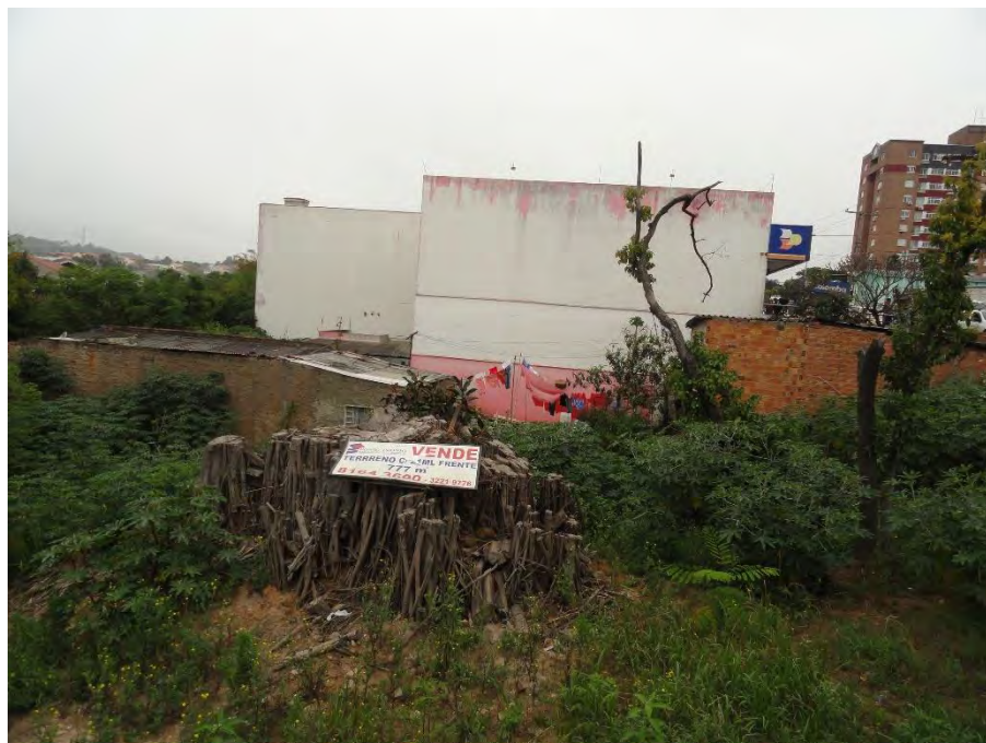
Foto 25: Lotes vazios junto à Av. Otto Niemeyer, bairro Cavalhada, exemplo de áreas parcialmente construídas. Setembro de 2013.
