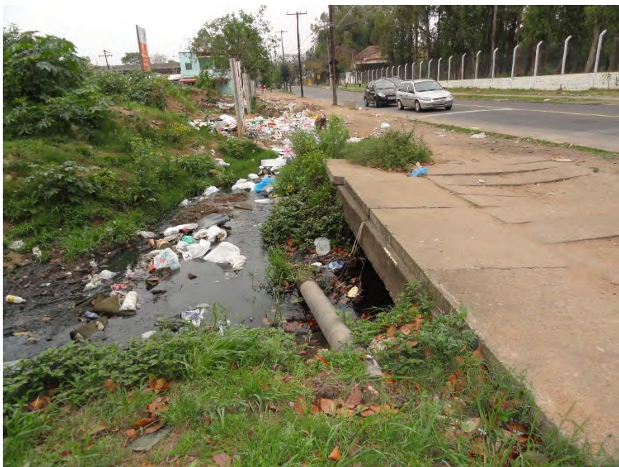
Foto 47: Canal de drenagem em superfície, formado a partir da escavação e concentração do fluxo de água, bairro Cristal. Setembro de 2013.
