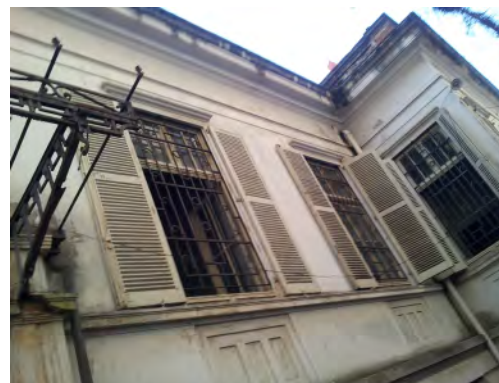
FIG 10: Lateral Oeste e acesso principal. FONTE: Autora
