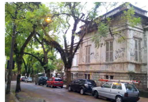
FIG 09: Fachada lateral leste do Palacete, voltada para a Rua Gen. João Manoel. FONTE: Autora
