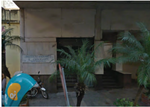
FIG. 38: Atual - e discreta - fachada do IHGRGS.
