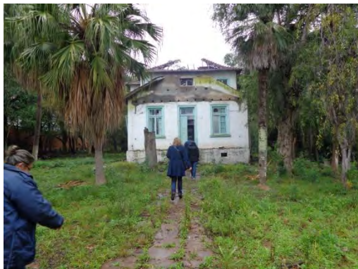
Situação atual da Casa dos Rosas após o último incêndio em 2013.*
