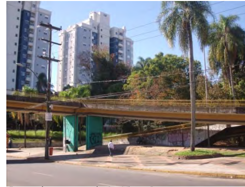
Frente do terreno pela Av. Victor Barreto com a rampa da passarela.
