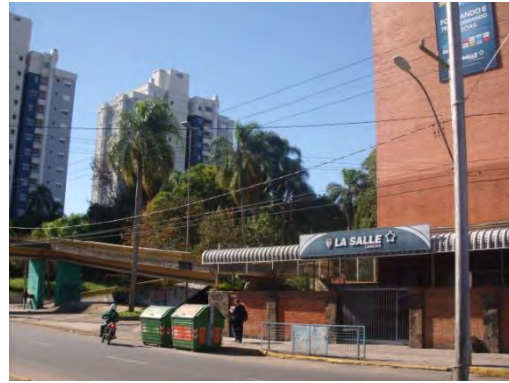
Terreno com seus vizinhos imediatos, Unilasalle a direita e torres residenciais a esquerda.
