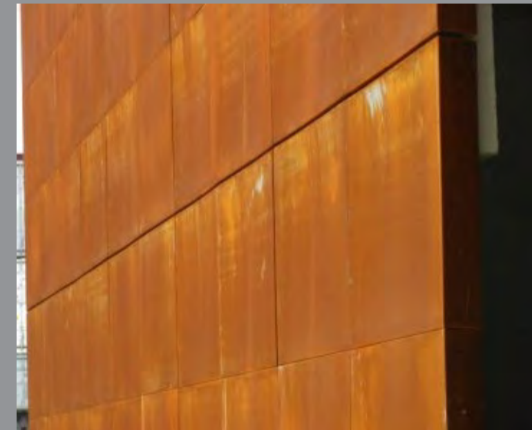
Chapa de Aço Patinável (Aço Corten) 2x1200x2500mm
