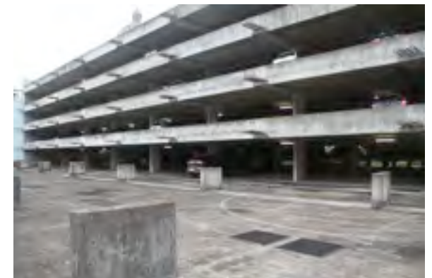
Edifício garagem, inacabado a partir do quarto pavimento.
