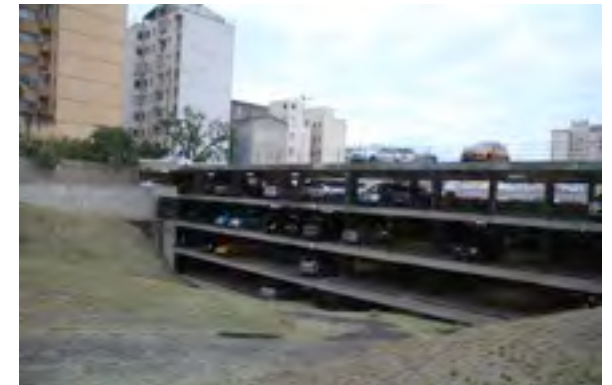
Topografia revela o edifício garagem como um cenário.
