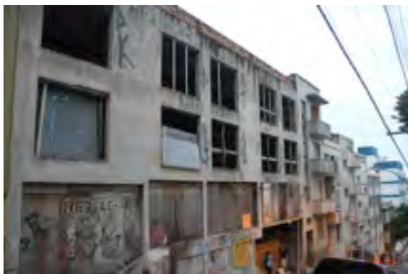
Edifício abandonado à rua Espírito Santo. Possível albergue.
