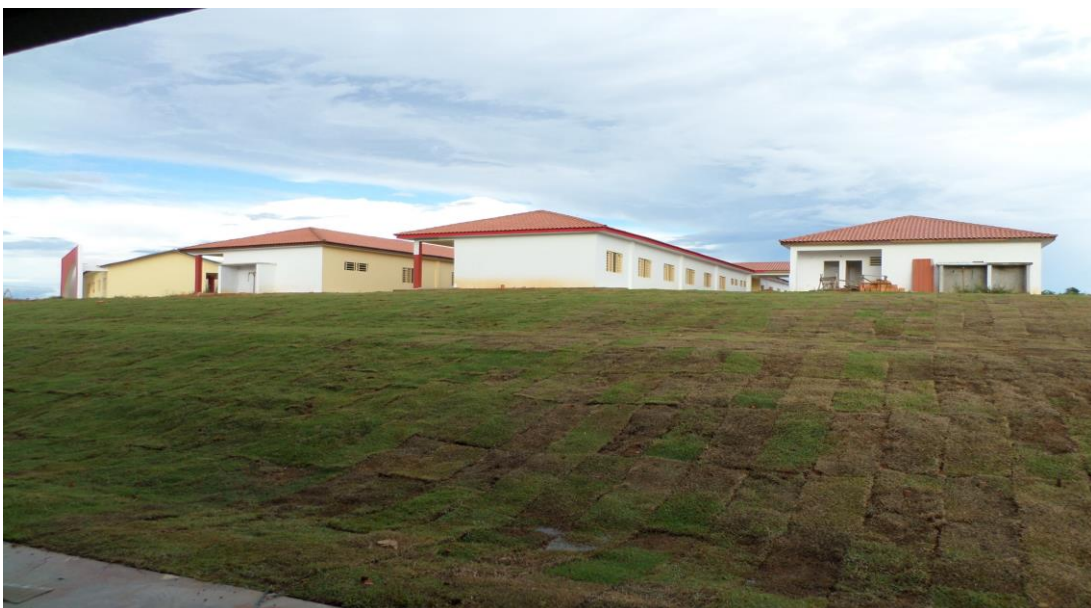
Novo prédio da Escola Estadual Terra Nova.
