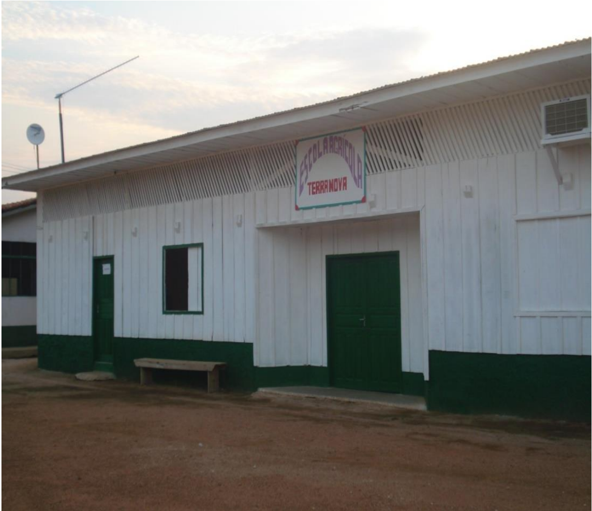
Prédio da Escola Estadual Terra Nova, adaptado do barracão da Associação de Agricultores 14 .
