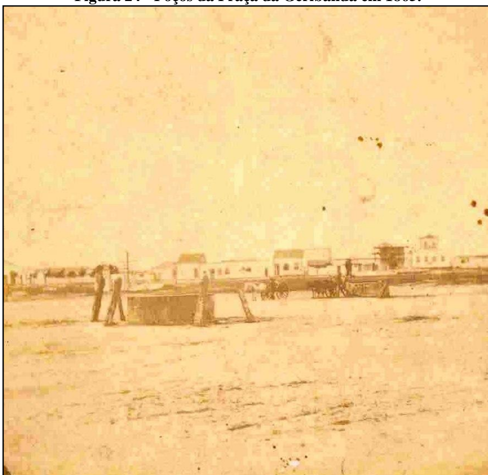
Figura 24 - Poços da Praça da Geribanda em 1865.
