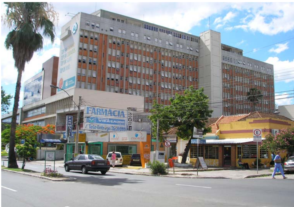
Figura 13: Vista da fachada lateral do Hospital Mãe de Deus em novembro de 2006 Fonte: Acervo do pesquisador
