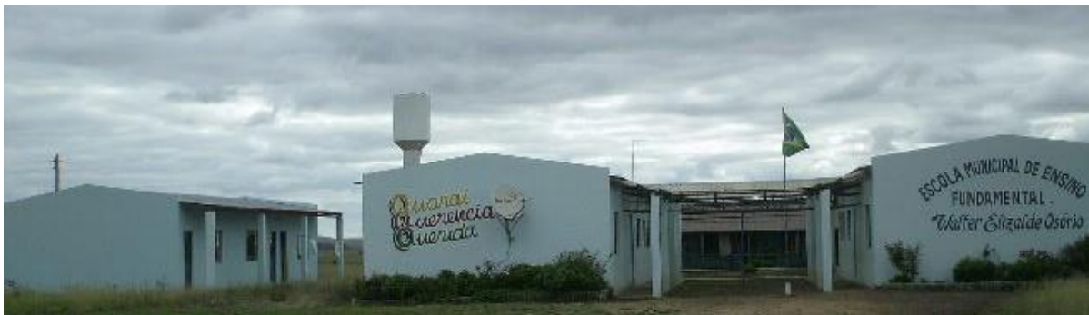
Figura 4 – Escola Municipal de Ensino Fundamental Walter Elizalde Osório
