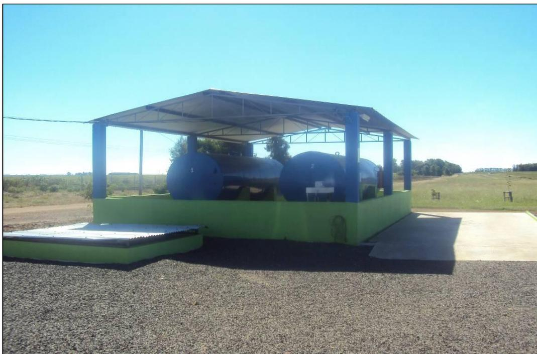
**FIGURA 5:** Tanque de combustível com bacia de contenção, piso impermeável e caixa separadora de água/óleo, Propriedade 3.
