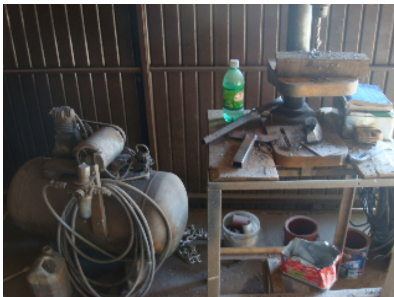
Figura 4.1 – Espaçamento irregular entre o vaso de pressão e a furadeira de bancada
