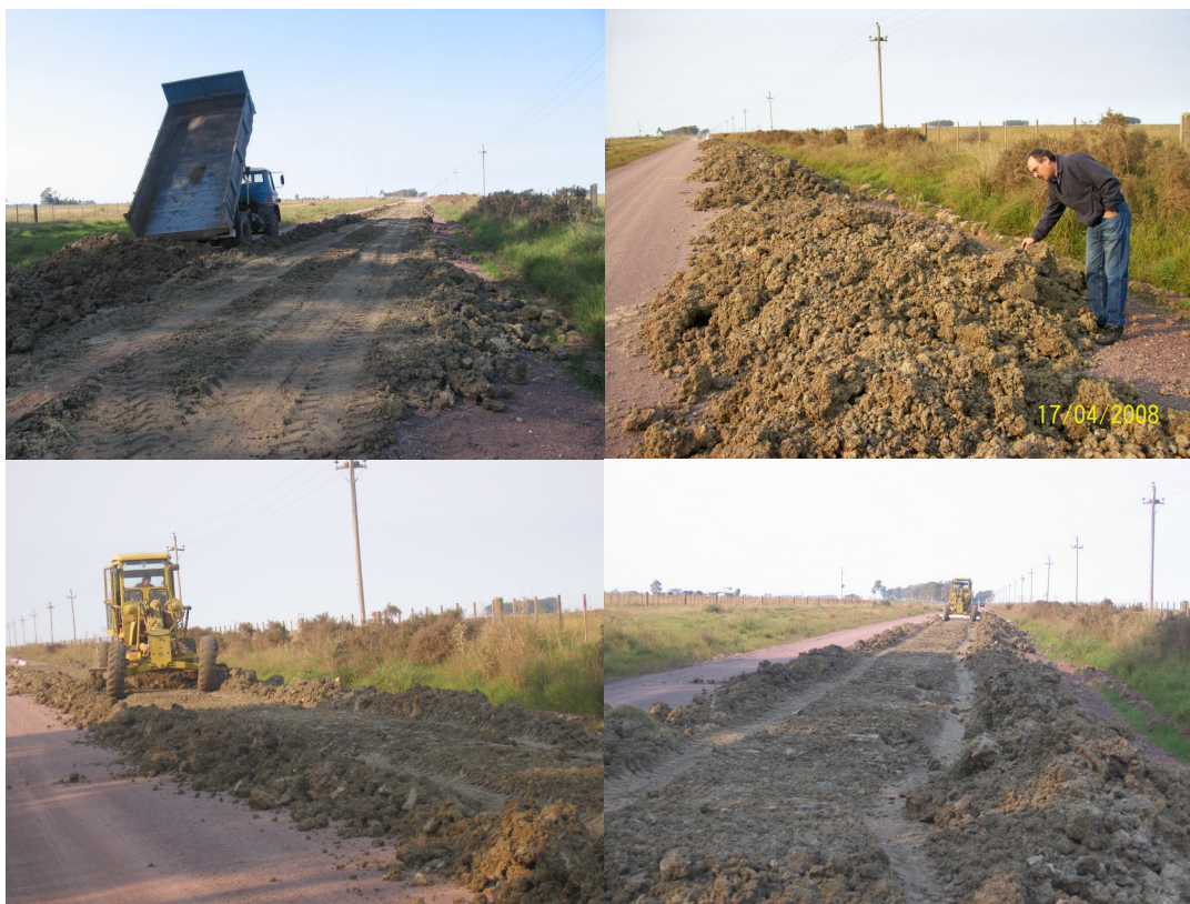
Figura 4.5. Operações de espalhamento do solo
