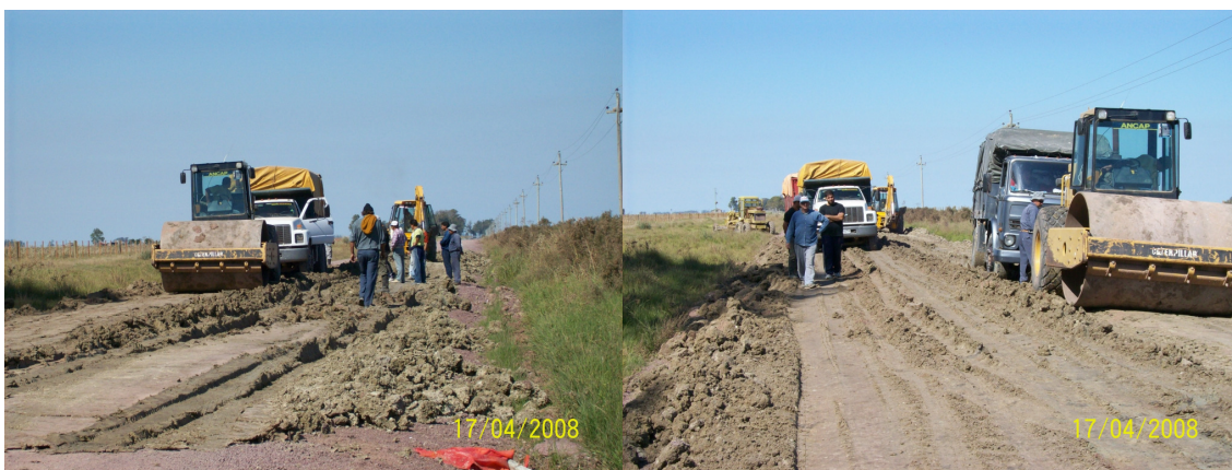
Figura 4.8. Compactação das camadas de solo-cal
