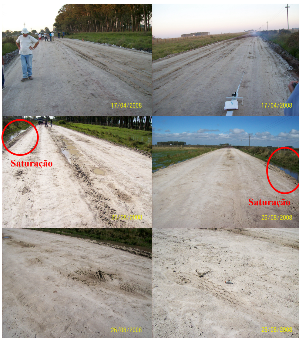
Figura 4.11. Condição superficial das camadas de solo-cal no TEP1 imediatamente após a construção (abril 2008) e quatro meses depois (agosto 2008)
