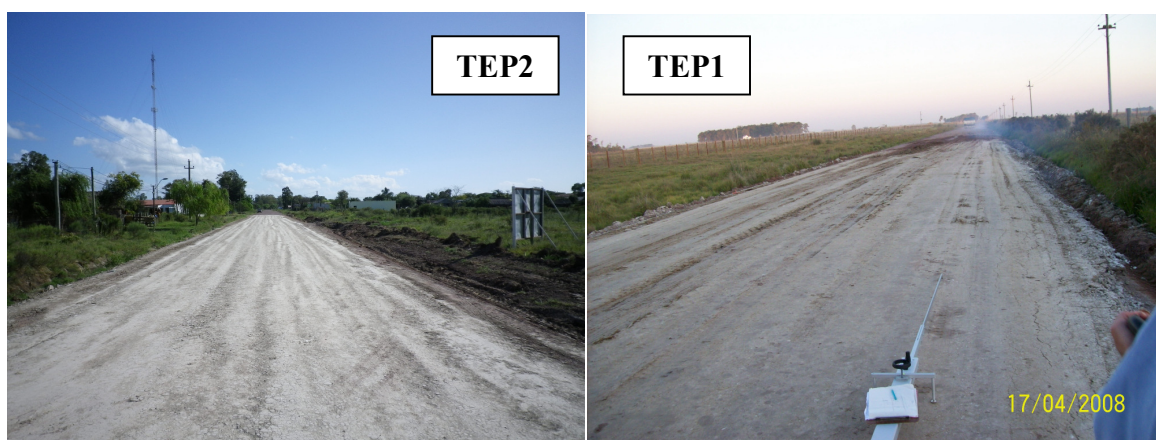
Figura 4.19. Condição superficial das camadas de solo-cal imediatamente após a construção do segundo trecho experimental e do primeiro trecho experimental
