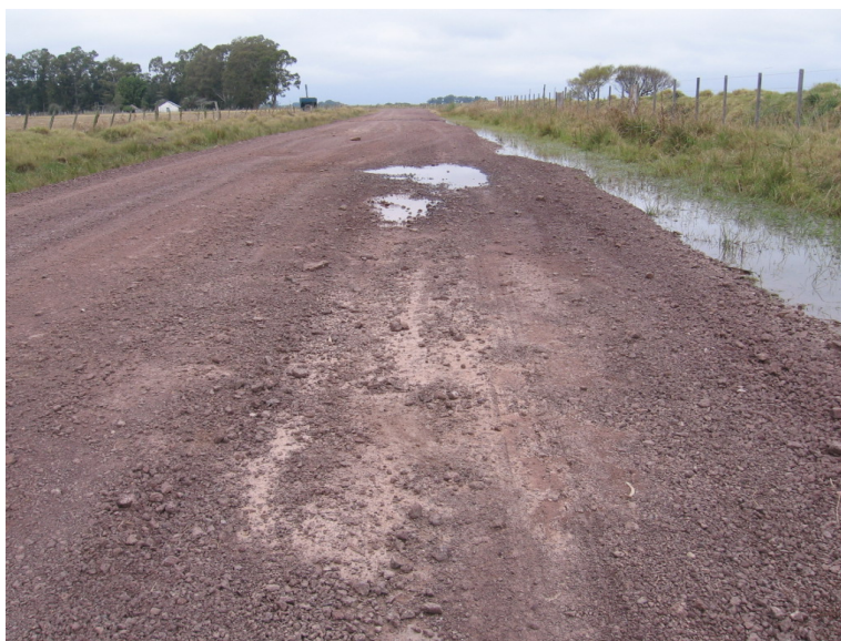
Figura 3.4. Estado do pavimento no local de construção do TEP1
