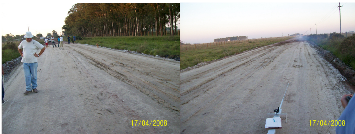
Figura 4.9. Condição superficial final de construção das camadas de solo-cal do primeiro trecho experimental
