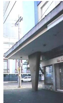
Fig. 407 – Edifício e Galeria Alda Assumpção Coluna em "v".
