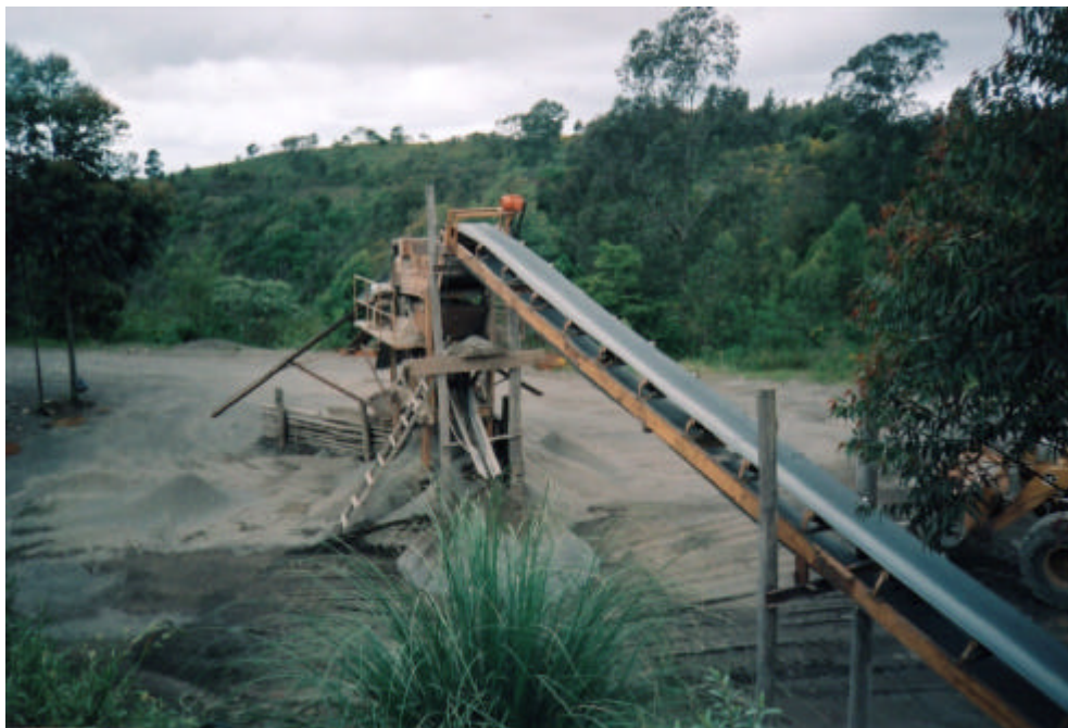
Figura 12 Foto Apresentação da Segunda Etapa do Processo de Britagem
