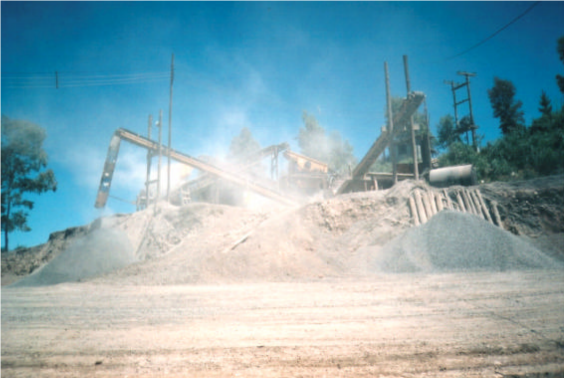
Figura 26 Foto Emissão de Poeira na Instalação de Britagem
