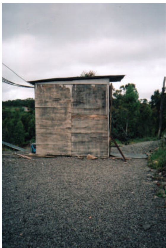
Figura 15 Foto Edificação para Operação de Quadro de Comando – Segunda Etapa
