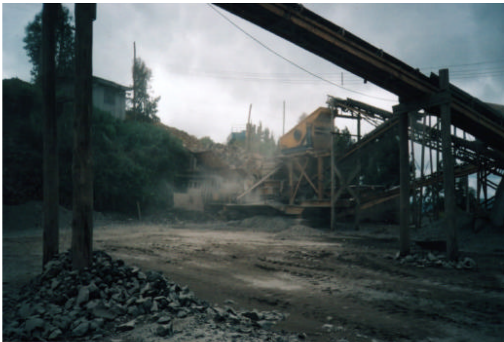
Figura 14 Foto Edificação para Operação de Quadro de Comando – Primeira Etapa
