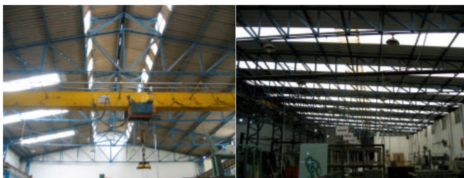
Figura 50: Iluminação natural e artificial da fábrica de vidros
