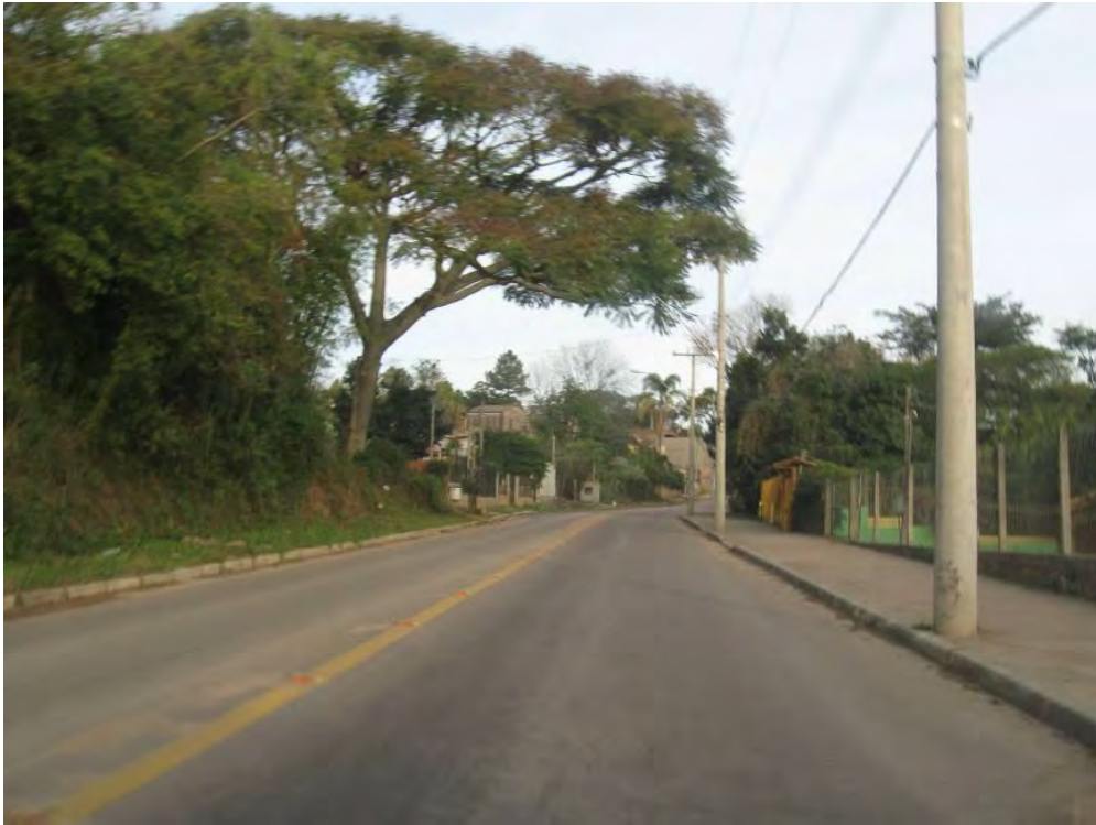
Figura 10 - Urbanização da Estrada Três Meninas, que antes era de chão batido, realizada pela empresa Alphaville Urbanismo. Fonte: Dorneles, 2012.
