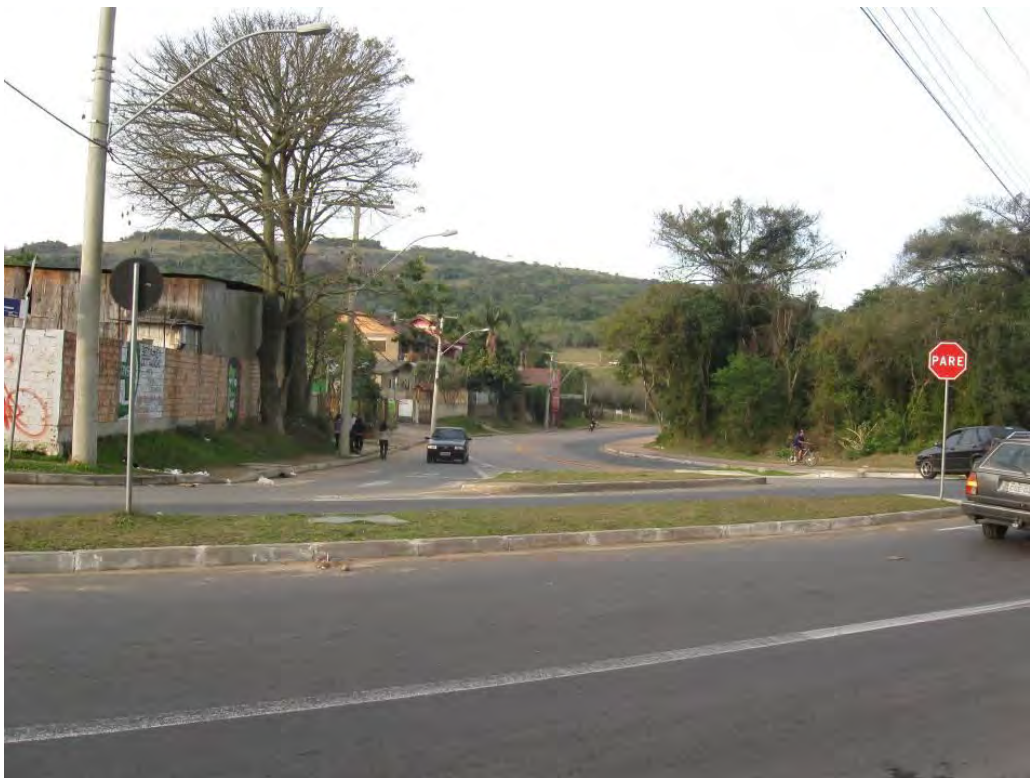
Figura 9 - Urbanização do cruzamento das Estradas Cristiano Kraemer e Três Meninas realizada pela empresa Alphaville Urbanism S/A. Fonte: Dorneles, 2012
