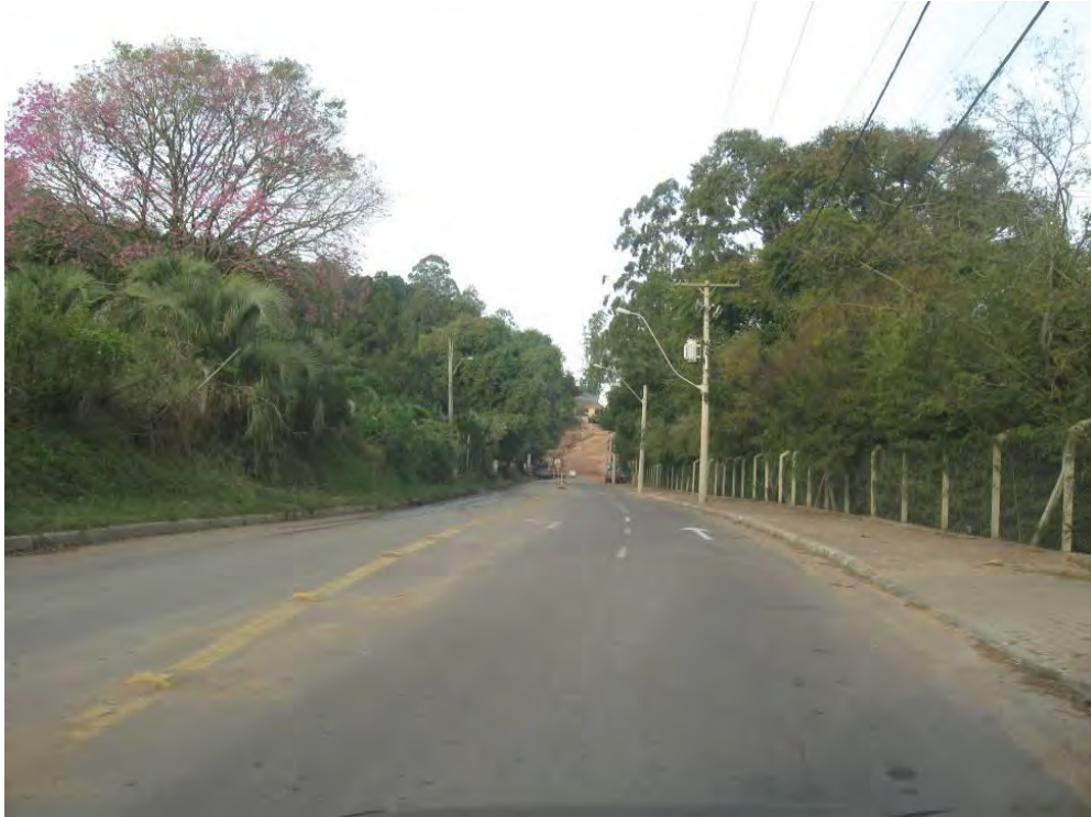
Figura 13 - Trecho da Estrada Três Meninas em obras e com acesso temporariamente restrito próxima ao condomínio. Fonte: Dorneles, 2012.
