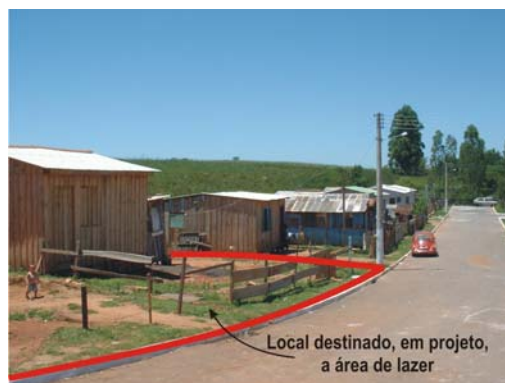
Figura 86: situação atual da área de lazer, destinada em projeto, AS-05.
