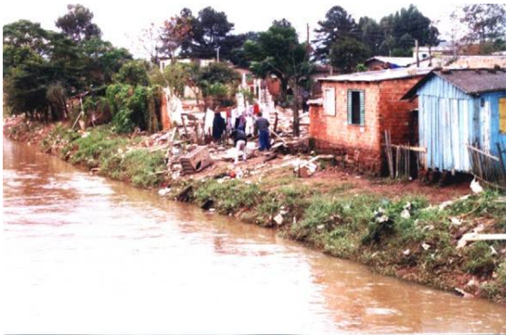
Figura 37: vista de uma área de risco às margens do Arroio Feijó. Fonte: PMA.
