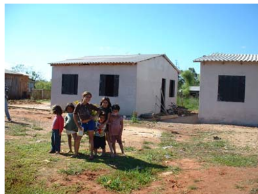
Figura 53: vista do AS-01, lotes sem divisão nítida.
