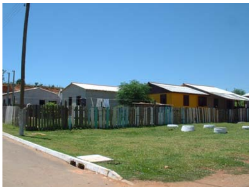
Figura 81: vista dos filtros anaeróbios, AS-05.
