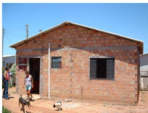
Figura 62: tipologia habitação em alvenaria sem reboco AS-05, Sítio dos Açudes.
