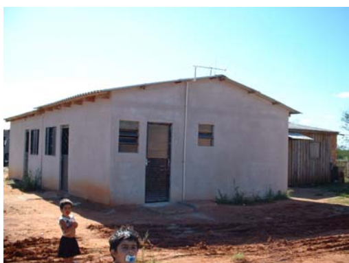
Figura 61: tipologia habitação em alvenaria rebocada AS-01, Sítio dos Açudes.
