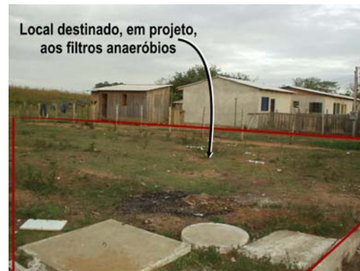
Figura 82: vista dos filtros anaeróbios, AS-04.
