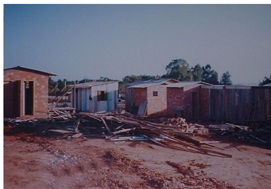
Figura 29: vista da montagem das habitações (PMA, 2000).
