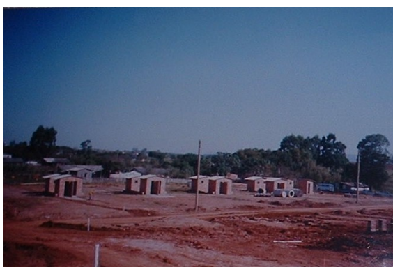
Figura 30: vista do local do Sítio dos Açudes, já com os WCs implantados (PMA, 2000).
