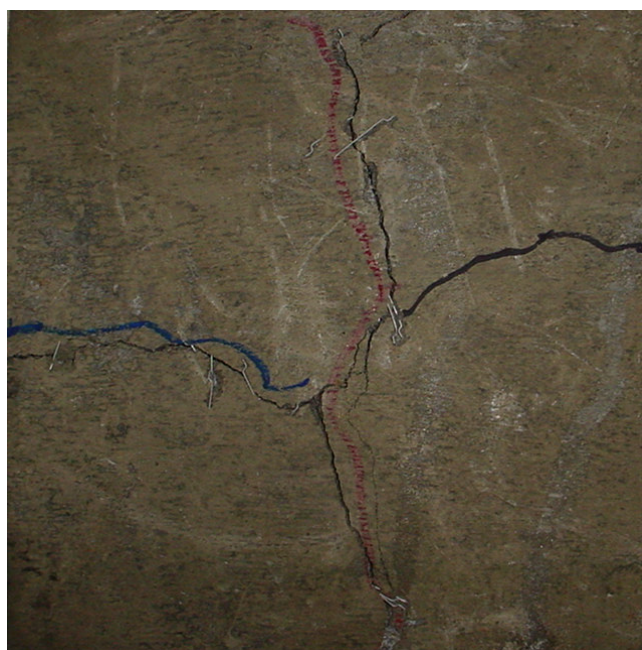
Figura 6.8 – Padrão de fissuração, ensaio experimental (Garcez, 2005).
