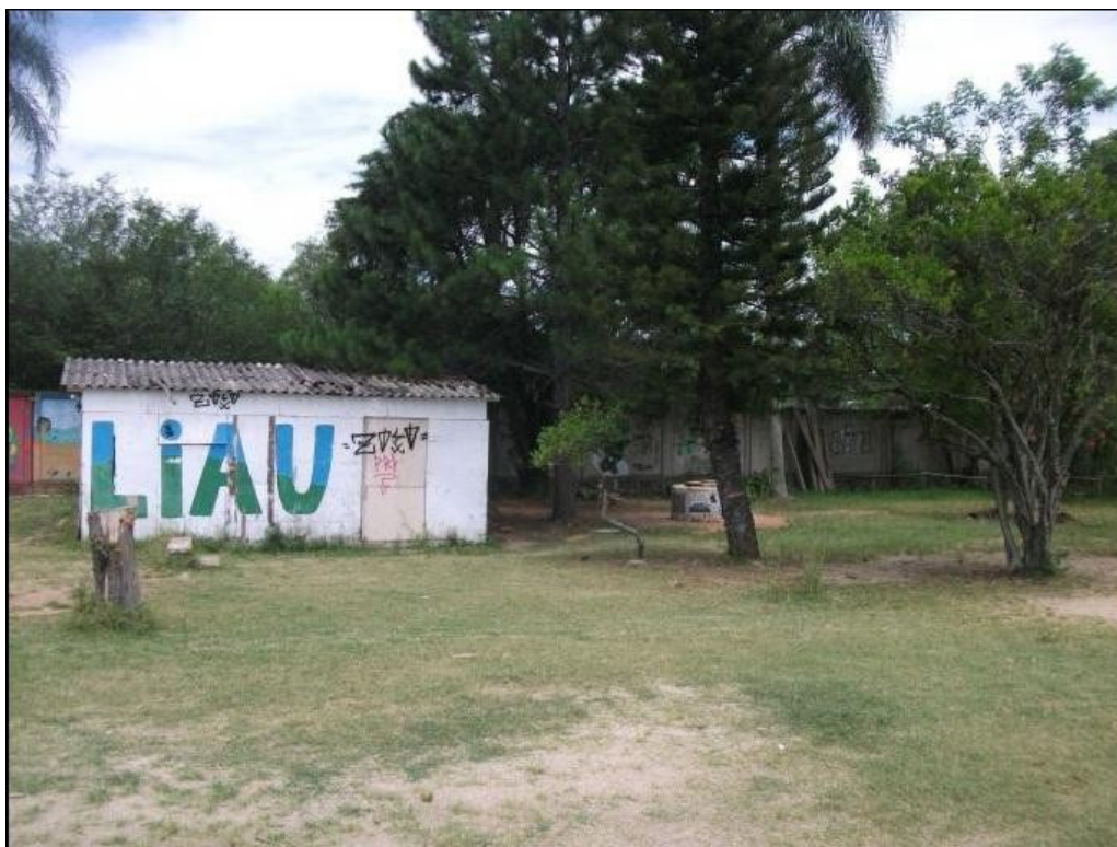
Figura 57- Antigo LIAU, adaptado de um galpão utilizado no período de construção da escola
