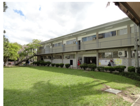
GINÁSIO 1 E SALAS DE AULA
