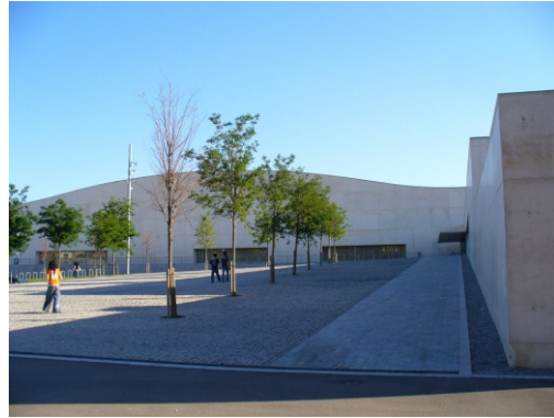
COMPLEXO DESPORTIVO RIBERA SERRALLO | ÁLVARO SIZA CORNELLA DE LLOBREGAT, BARCELONA
