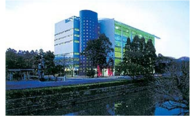
COMPLEXO ESPORTIVO DA PUCRS | SANTINI E ROCHA ARQUITETOS PORTO ALEGRE, RS, BRASIL
