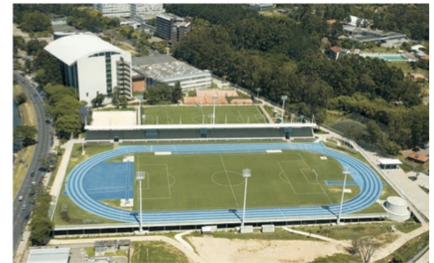
COMPLEXO ESPORTIVO DA PUCRS | SANTINI E ROCHA ARQUITETOS PORTO ALEGRE, RS, BRASIL
