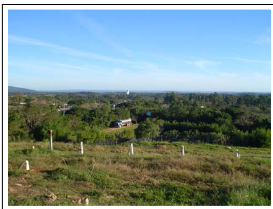
Figura 27: Desativação do ASE com frente concluída (jul/2005)
