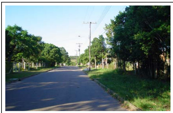
Figura 21: Pavimentação no acesso ao aterro (nov/2005)
