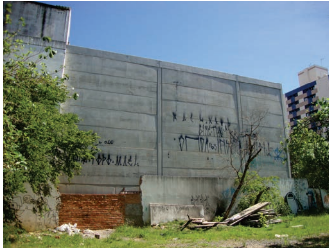
fachada cega do estacionamento
