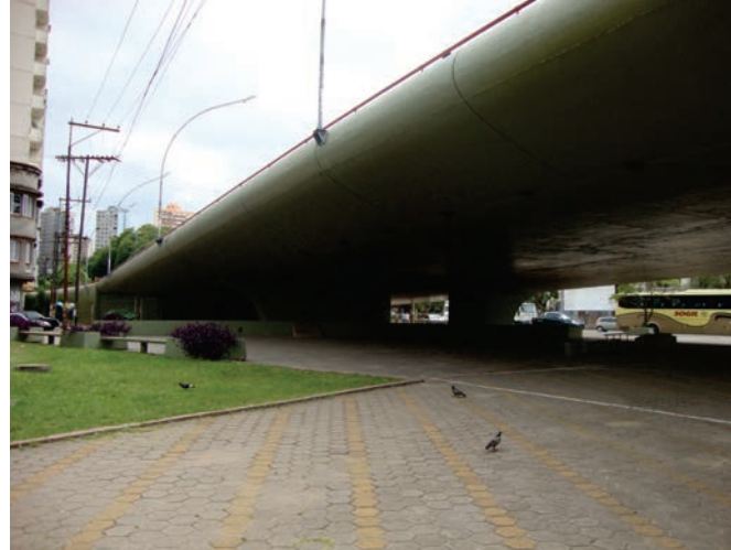
viaduto da av. João Pessoa
