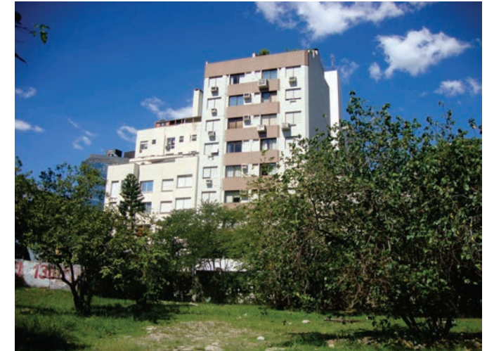
edifícios nos fundos do terreno
