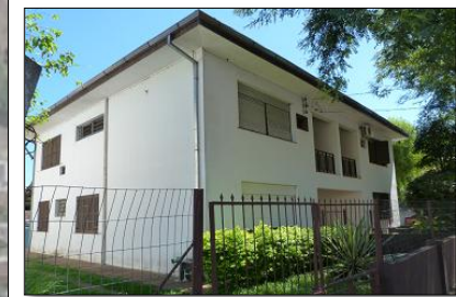
3 e 4 – Edificações dos Bombeiros
