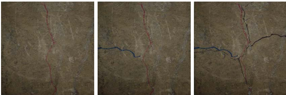
Figura 6.17 – Padrão de fissuração das placas submetidas a cargas de impacto.
