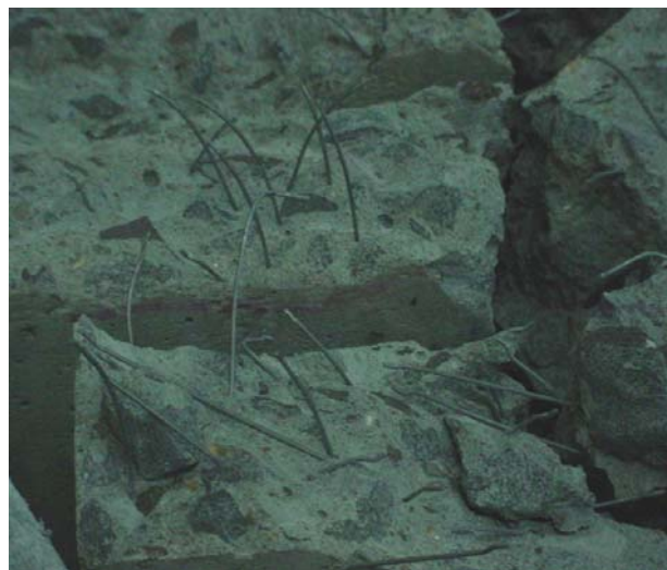
Figura 2.7 – Amostras de concreto reforçado com fibras de aço após a ruptura.
