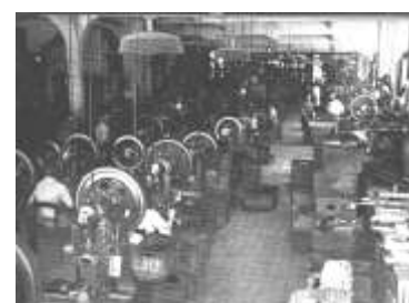
Figura 2.78 Estrutura modulada na Metalúrgica Eberle
