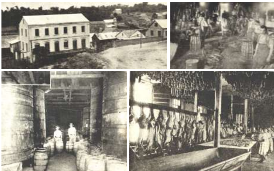
Figura 2.42 Complexo da Cantina Pieruccini: vista geral, tanoaria, cantina e fábrica de salames – início século XIX
