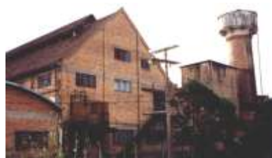
Figura 2.119 Um dos galpões e caixa d'água da Cantina Michielon
