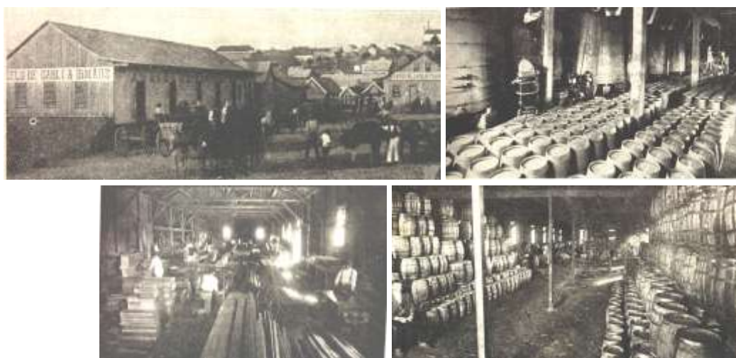
Figuras 2.43 Complexo da Cantina Irmãos De Carli e Paganelli: vista geral, cantina, depósito de madeira, tanoaria – 1918
