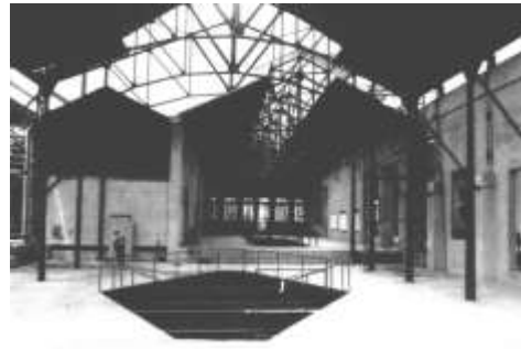
Figura 1.66 Estrutura e treliça em ferro da Fundação Progresso. Rio de Janeiro
