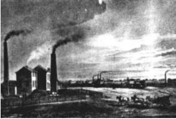
Figura 1.9 Ilustração da Mineradora de Carbono Soc. Boa Esperança. Montegnies-sur-Sambre – 1852
