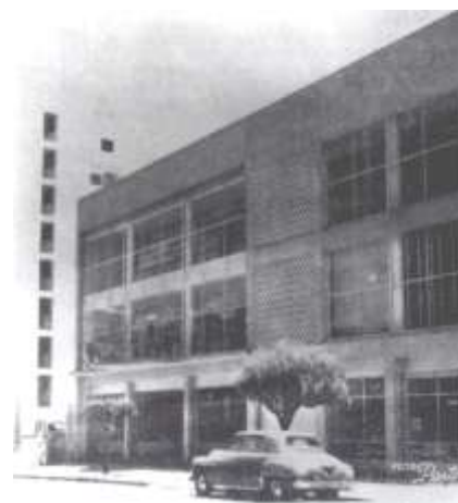
Figura 2.131 Ferragem Caxiense S. A., na Rua Sinimbu
