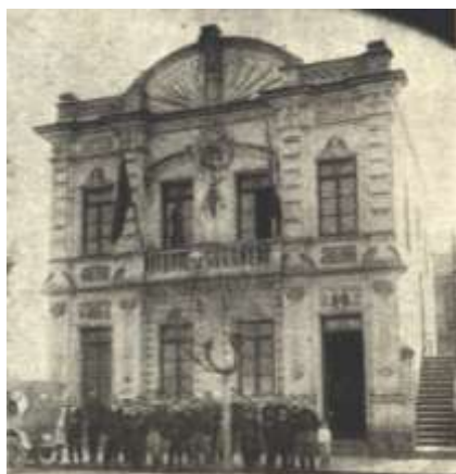
Figura 2.36 Sede da Sociedade "Principe di Napoli", na Rua Garibaldi
