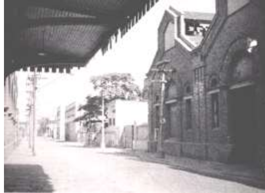
Figura 1.63 Marcação da estrutura e oitões. Fábrica no Brás. São Paulo
