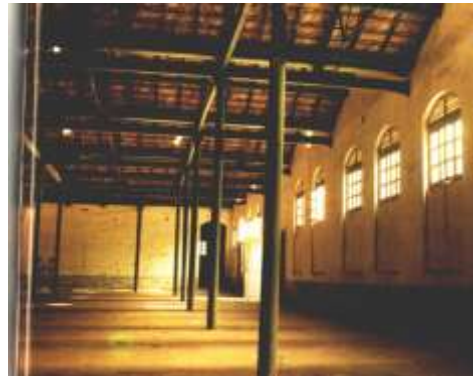
Figura 1.67 Estrutura em ferro da Fábrica Têxtil Rio Anil. São Luiz do Maranhão – 1891-1893
