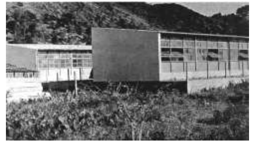
Figura 1.84 Ateliers Petrópolis, Rocha Miranda
