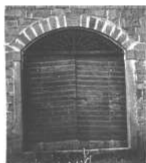
Figura 2.22 Verga em arco abatido, com bandeirola fixa
