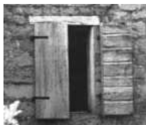
Figura 2.20 Tampões de abrir para fora
