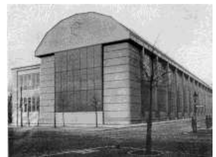
Figura 3.5 Pavilhão da AEG, de Peter Behrens, construído em 1908
