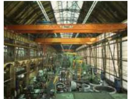
Figura 1.53 Vista interna da AEG - pé-direito alto, com espaço para a corrida das guias
