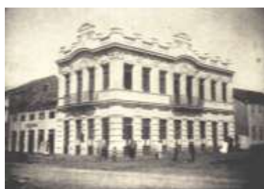
Figura 2.32 Sede do Banco Pelotense
