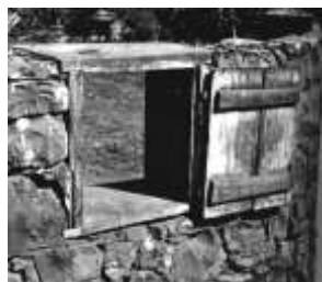
Figura 2.19 Prolongamento de peitoril e verga para estruturar marco
