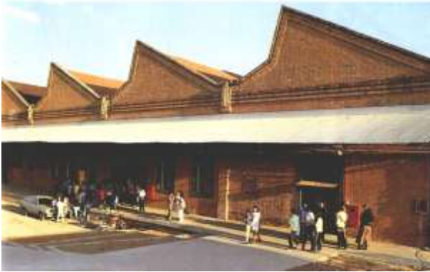
Figura 1.62 Marcação da estrutura e molduras na linha dos sheds . Fábrica na Lapa. São Paulo
