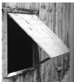
Figura 2.21 Tampão fixado na verga
