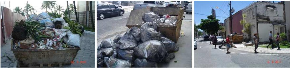
Figura 4.31 – Caçambas descobertas e inadequadas.
