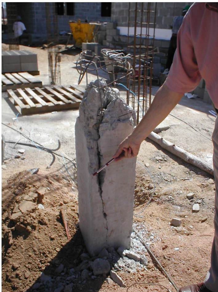
Figura 26: Patologia ocorrida no processo de cravação de uma estaca pré-moldada de concreto
