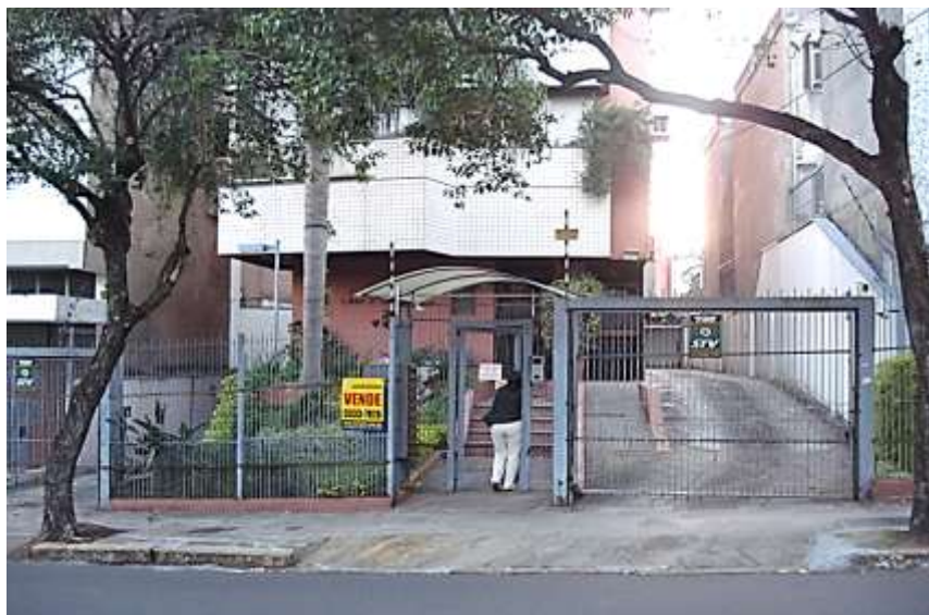
Figura 5: Edifício na Rua Lima e Silva, 1509 (área onde ficava o Recanto Santanense)
