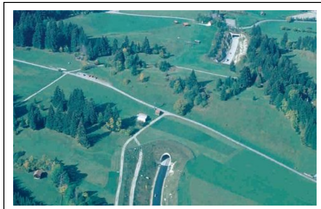
Figura 44. Túnel na Alemanha, com área superior proporcionando uso misto (humano e fauna) (IUELL et al. 2003).
