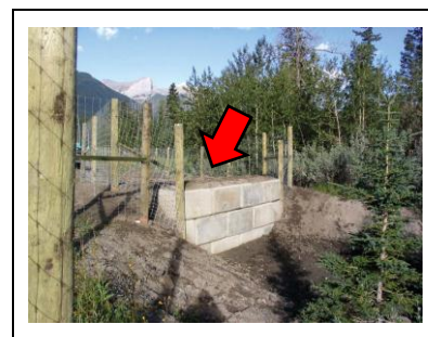
Figura 91. Cerca com rampa de escape (seta) para retorno de animais da rodovia para as áreas adjacentes (CLEVINGER & HUIJSER 2011).
