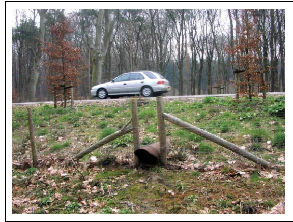
Figura 23. Túnel para pequenos mamíferos, com cerca direcionadora (CLEVINGER & HUIJSER 2011).
