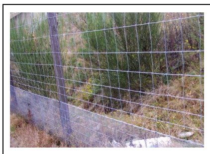
Figura 89. Cerca com combinação de malhas fina e larga (CLEVINGER & HUIJSER 2011).
