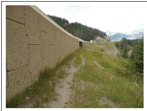
Figura 96. Solo estabilizado mecanicamente, por meio de geogrelhas estruturais, servindo como cerca direcionadora (CLEVINGER & HUIJSER 2011).
