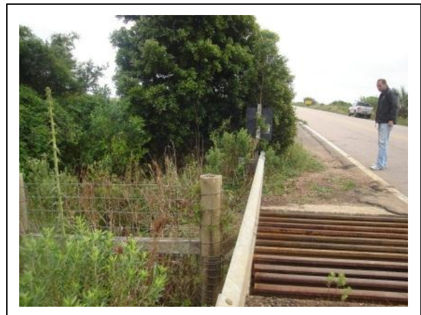
Figura 97. "Mata-burro" instalado para evitar a entrada de animais no segmento cercado. BR 471/RS, Santa Vitória do Palmar. Foto: José Antonio Palmeiro Gudolle, NLA/IBAMA/RS.
