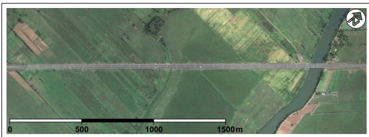
Figura 49. Elevada com cerca de 2.100 m de extensão na BR 101/RS, várzea do rio Maquiné. Imagem Google Earth 2010. (Coord. Geogr. 50°10'53"W / 29°42'23"S, WGS84)
