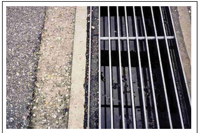
Figura 29. Duto subsuperficial para anfíbios, recoberto por grades (CLEVINGER & HUIJSER 2011).
