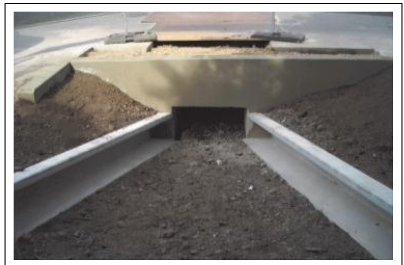
Figura 31. Entrada de túnel para herpetofauna (BARKER 2009).
