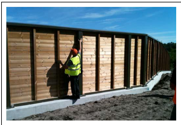
Figura 61. Barreira acústica na França (JONES 2010).
