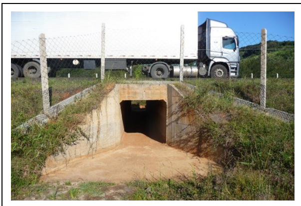
Figura 20. Passagem de fauna em bueiro celular 1,5 x 1,5 m, BR 101/RS.
