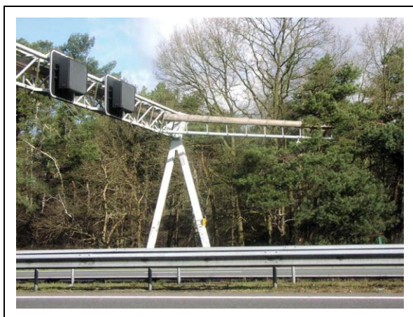
Figura 41. Passagem instalada na sinalização da rodovia (CLEVINGER & HUIJSER 2011).
