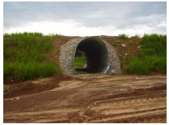
Figura 27. Passa-gado em tubo corrugado. Foto: Norma Ambiental VALEC nº 15/2010 (www.valec.gov.br).
