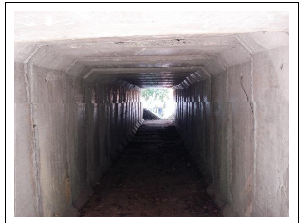
Figura 19. Instalação de passagem de fauna em bueiro celular. Rodovia BR 101/RS.
