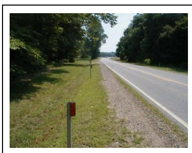
Figura 79. Refletores instalados em rodovia americana. Foto: www.strieter-lite.com
