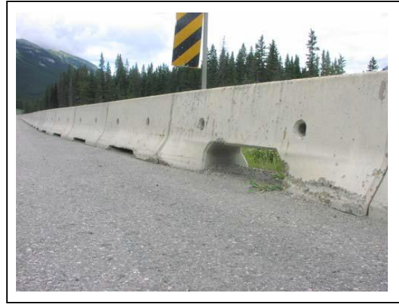
Figura 64. Barreira Jersey com passagem para fauna (CLEVINGER & KOCIOLEK 2006).
