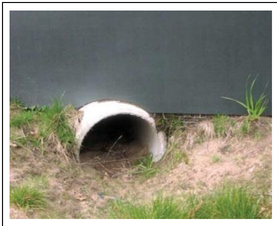
Figura 28. Túnel para herpetofauna com barreira direcionadora (CLEVINGER & HUIJSER 2011).
