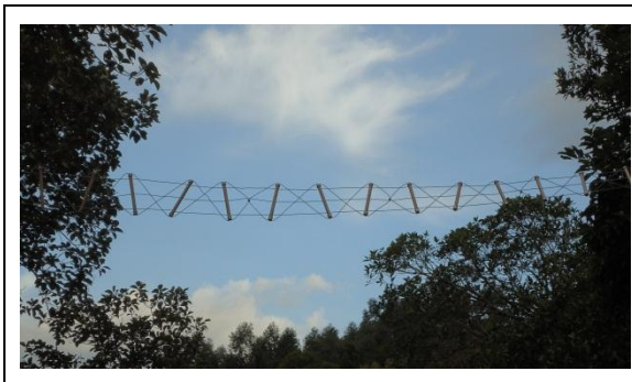
Figura 39. Passagem aérea instalada na rodovia SC 450, Praia Grande. Foto: Rodney Schmidt – IBAMA, processo de licenciamento ambiental nº 02001.002695/2005-01.
