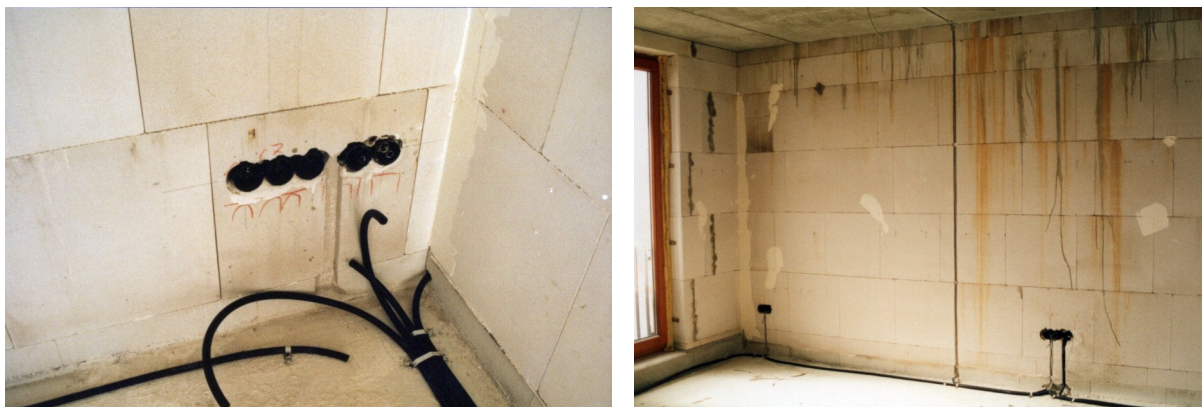
Figura 99: rasgos nas paredes para embutir a instalação elétrica
