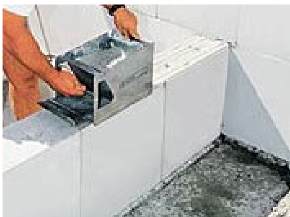
Carrinho dosador para execução da junta horizontal (KALKSANDSTEIN, 2004)
