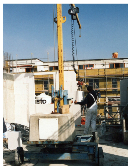
Figura 94: assentamento das unidades de grande dimensão com auxílio de uma grua pequena
