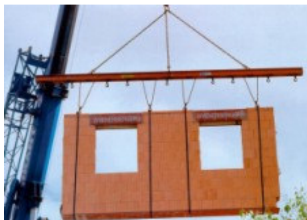
Ïaçamento de parede pré-fabricada (SCHÖPS, 2003)
