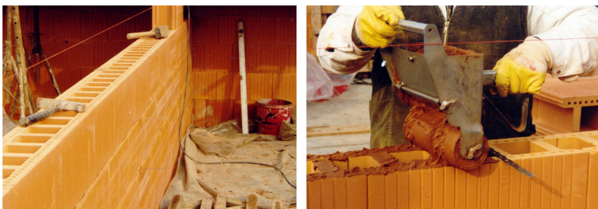
Figura 84: execução da parede divisória entre as residências com unidade especial para isolamento acústico
