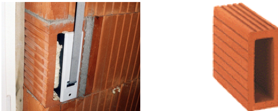
Figura 90: unidade para enrolar a fita da persiana (EDER, 2004)
