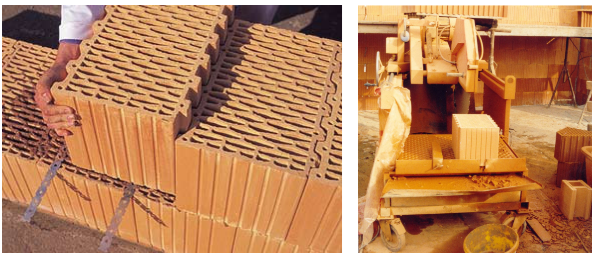
Figura 82: unidade externa com encaixe macho-fêmea (EDER, 2004) e equipamento utilizado para cortar as unidades
