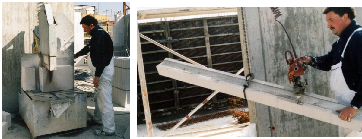
Figura 96: equipamento utilizado para cortar as unidades e unidade em forma de verga
