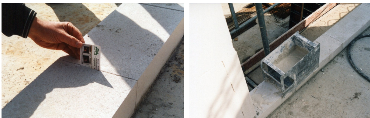
Figura 95: espessura da junta e carrinho dosador
