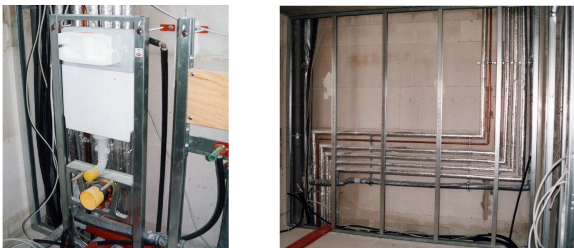
Figura 101: shafts hidráulicos do banheiro e da cozinha
