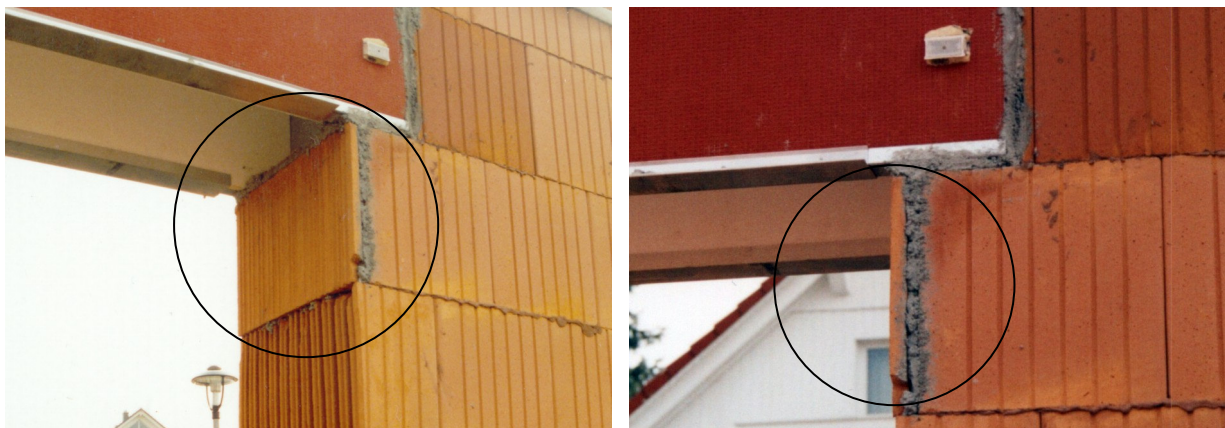
Figura 83: unidade cortada para preencher o espaço que faltava e completar a medida da parede em 1 cm
