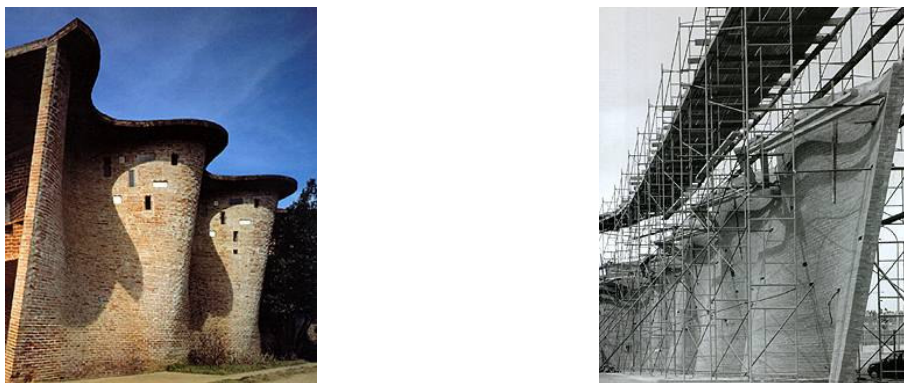
Figura 30: Igreja de Atlântida e construção da Igreja San Juan de Avila de Eladio Dieste (ELADIO DIESTE, 2003)
