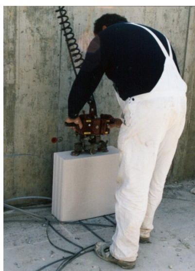
Figura 94: assentamento das unidades de grande dimensão com auxílio de uma grua pequena
