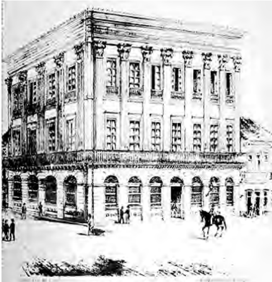
Figura 4.5.2 - Prédio projetado (cerca de 1853) para o Banco Comercial do Rio de Janeiro e posteriormente usado para sede do Banco do Brasil, rua da Alfândega esquina com rua da Candelária, Rio de Janeiro / RJ. Manoel de Araújo Porto Alegre. Perspectiva. MONTEIRO, Fernando. A Velha Rua Direita . Rio de Janeiro, 1985. Editado por Museu e Arquivo Histórico do Banco do Brasil, p.97.
