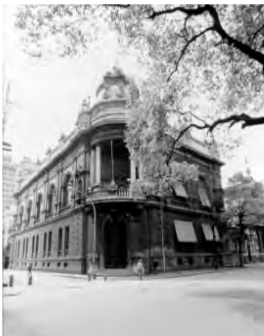
Figura 4.5.3 – Prédio construído para a primeira sede Banco do Brasil (1892-97), na rua 1° de Março esq. rua do Rosário, Rio de Janeiro / RJ - Luís Schreiner. Foto de Ruy Corrêa.
