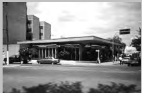
Figura 9.3.40 - Caixa Econômica Federal, agência Torres / RS. Jorge Decken Debiagi. Foto do autor.
