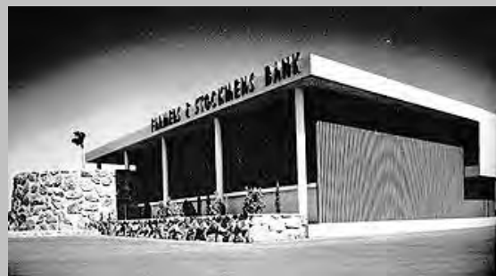
Figura 9.1.7 - Farmers & Stockmen's Bank, Phoenix, Arizona. Pereira & Luckman. Progressive Architecture , outubro de 1952, p. 90.
