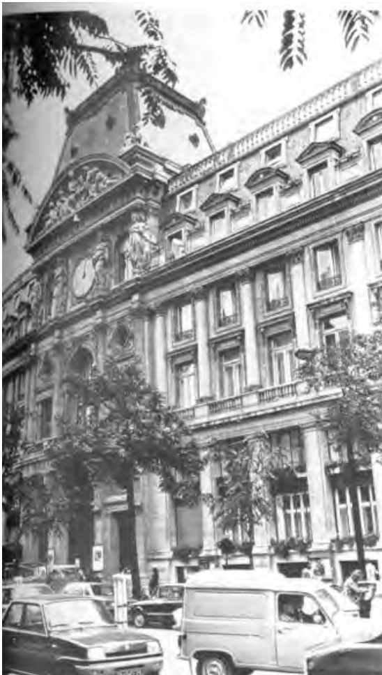
Figura 4.6.5 – Crédit Lyonnais – fachada do Boulevard des Italiens, Paris. Willians Bouwens Van der Boijen. L'Architecture d'aujourd'hui , n° 176 – nov./dez. 1974 – p. 31.
