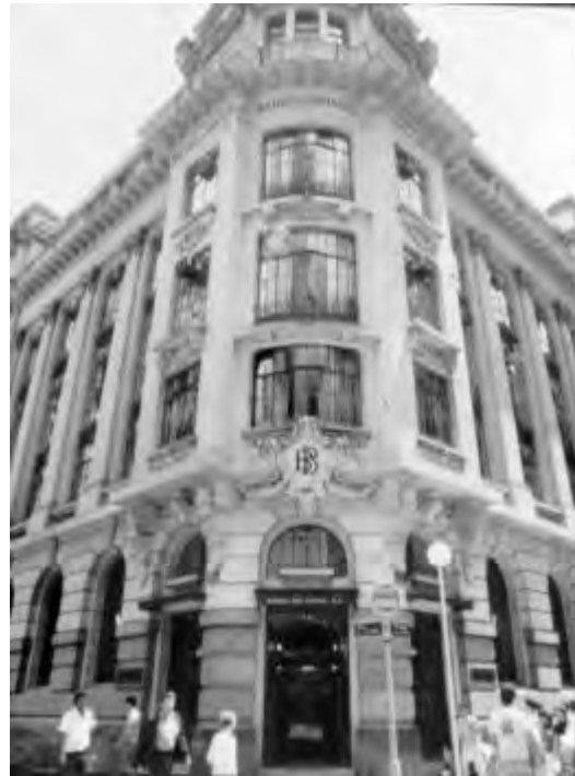
Figura 8.3.12 - Banco do Brasil, prédio para agência localizado na rua da Quitanda esq. rua Álvares Penteado, São Paulo / SP- 1927. Estúdio Pujol. Foto do autor.
