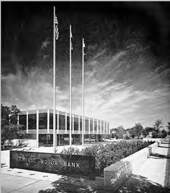
Figura 9.1.14 - Central Motor Bank, Jefferson City, Missouri. Skidmore, Owings & Merrill Architectural Record , Setembro de 1963, p.157.
