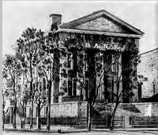
Figura 9.1.23 - First National Bank of Shawneetown, Illinois, 1836. Architectural Forum , outubro de 1961, p.98.
