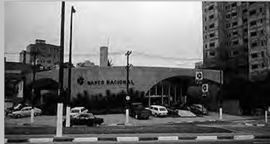
Figura 9.3.32 - Banco Nacional, agência Sumaré, São Paulo / SP. Sidônio Porto. Foto do autor.
