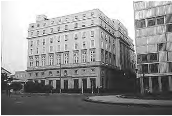
Figura 4.5.8 - Banco do Brasil, Centro Cultural, rua Primeiro de Março, Rio de Janeiro / RJ. Foto do autor.
