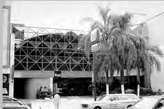
Figura 9.3.43 - Banco Itaú, agência Moinhos de Vento, Porto Alegre / RS. Foto do autor.
