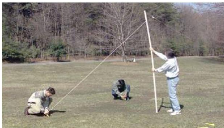
Figura 7: Fotografia do início da montagem de uma antena nos Estados Unidos - fixando o primeiro mastro, colocando os dipolos um de cada vez.
