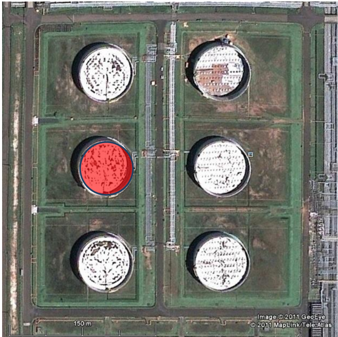
Figura 5 - Imagem de satélite do tanque sinistrado e equipamentos adjacentes.
