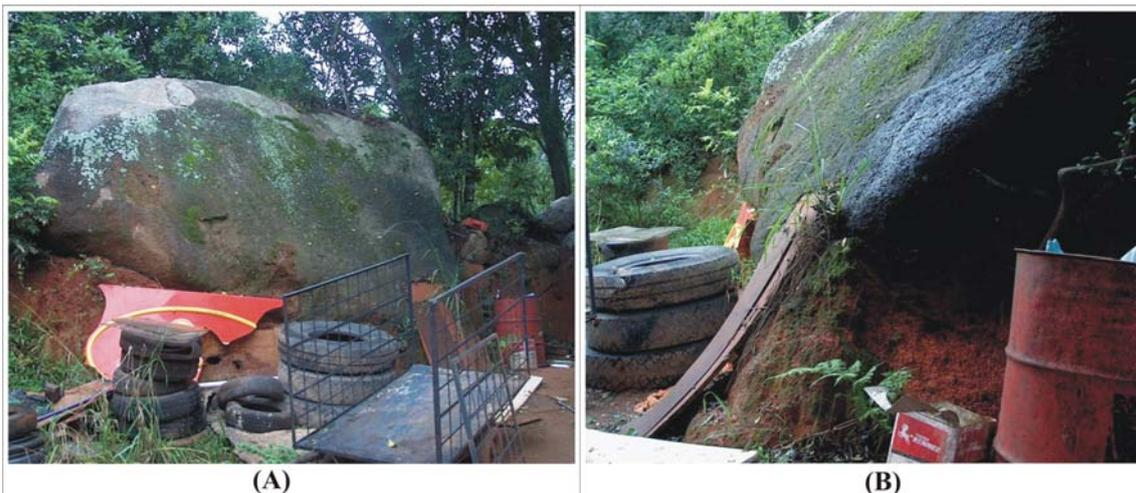
**Fotografia 01 - (A) Corte em terreno expondo matacões. (B) Em detalhe: manto de alteração sob o Granito Saint Hilaire. Localização: fundos do Galpão de Reciclagem no loteamento Augusta Meneguini (coordenadas UTM: 492475; 6675410 - 13/04/2005).**
