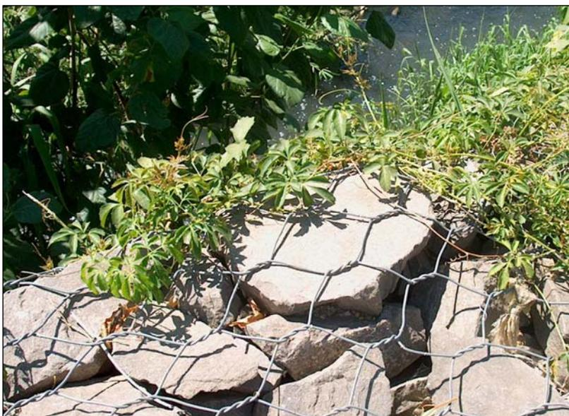
**Fotografia 16 – Uso de muro de defesa hidráulica (muro gabião), constituído por rede de arame e rochas, para contenção do solapamento das margens do arroio Dorneles (coordenadas UTM: 492267; 6675724 - 12/03/05).**
