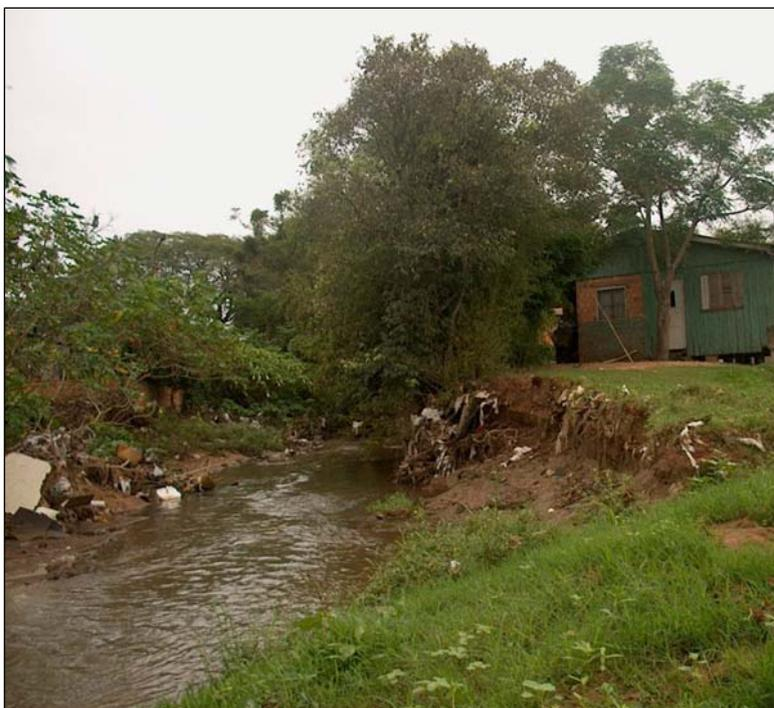
**Fotografia 13 - Seção do arroio Dorneles localizada entre obras de intervenções estruturais hidráulicas com margem côncava em intenso processo de solapamento (coordenadas UTM 492362, 6675276 - 13/04/2005).**
