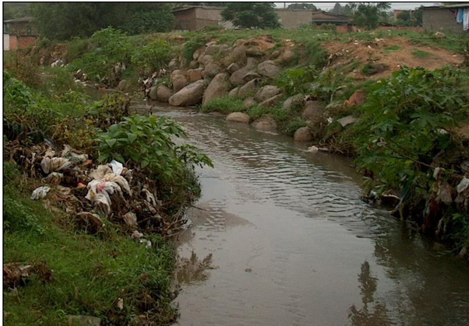
**Fotografia 12 - Introdução de matacões para contenção de solapamento na margem côncava do arroio Cecília (coordenadas UTM 492220, 6675110 - 13/04/2005).**
