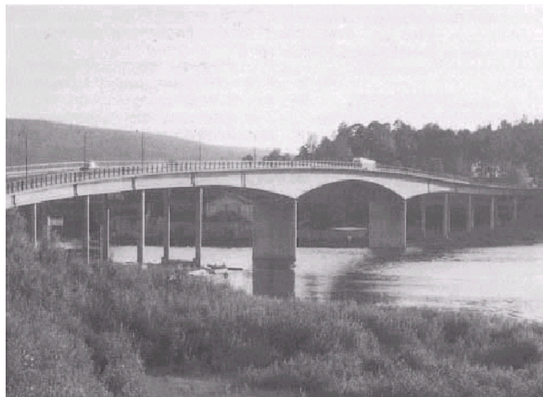
Figura 1.4 – Ponte Klockestrand Sound, perto de Estocolmo (VSL International, 1992)
