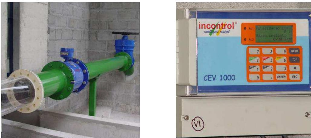
Figura 21. Detalhes do medidor de vazão e painel de visualização
