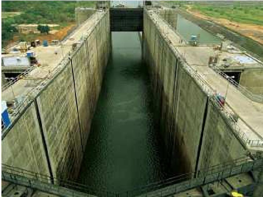
Figura 3. Eclusa de alta queda – Tucuruí – PA (Fonte: ELETRONORTE, 2011)
