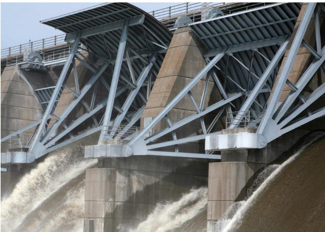
Figura 4. Comportas tipo segmento instalada em vertedor.(USACE, 2010)
