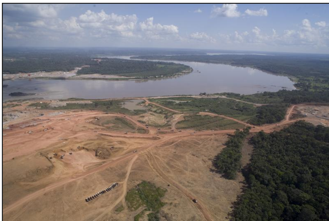
Figura 17. Solo exposto nas obras de construção da hidrelétrica de Santo Antônio-RO. Fonte: Santo Antônio Energia.
