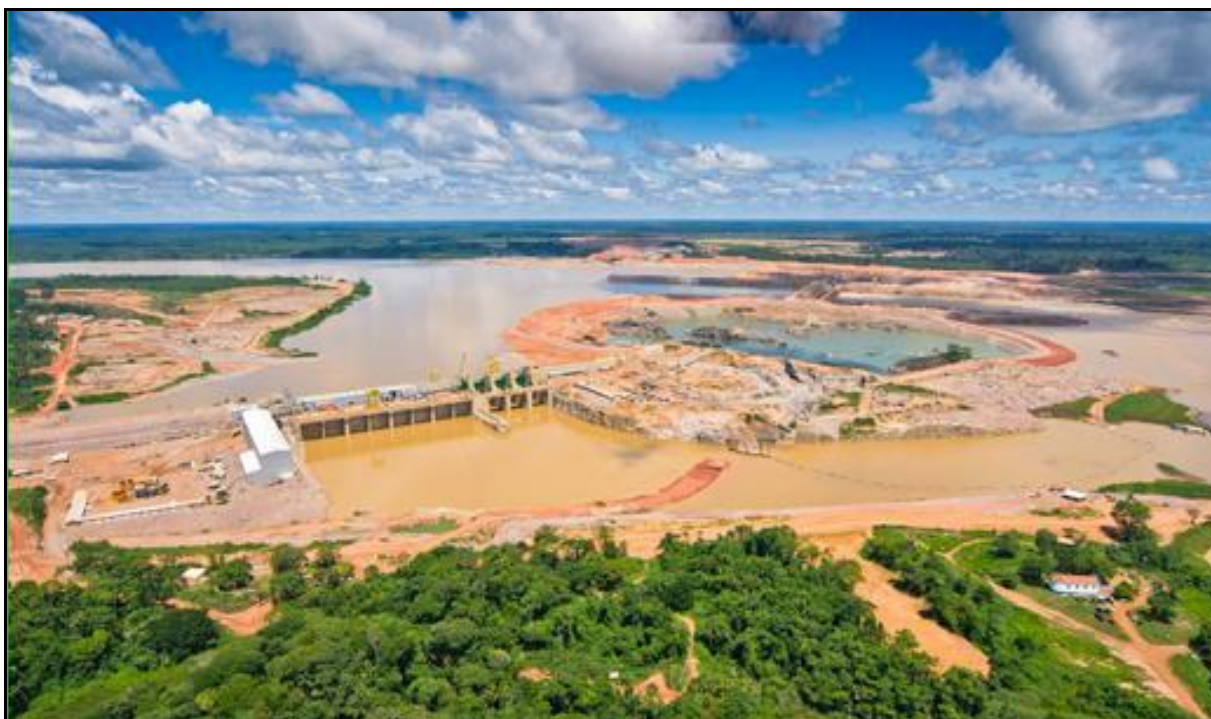
Figura 4. Hidrelétrica de Santo Antônio, Porto Velho, Rondônia. Fonte: Santo Antônio Energia (2011).
