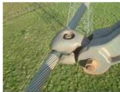
(d) Garra do espaçador amortecedor
