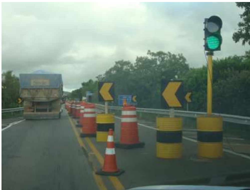
Figura 16 : Bloqueio Parcial de Pista com Utilização de Semáforo
