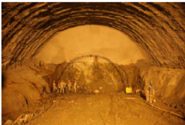
Figura 7.1: foto do túnel estação durante sua escavação e começo da escavação do túnel de via (original IPT 2008)
