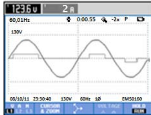
Figura 4.12 – Medição realizada com o analisador Fluke 435, com ponteira de 40 A, na rede elétrica com o microcomputador.
