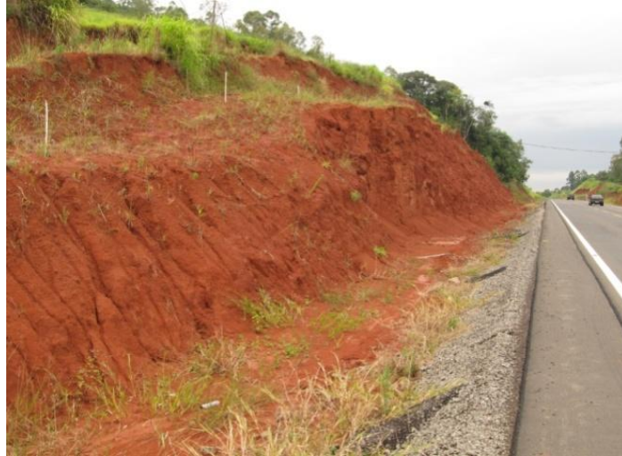
Figura 3.11: Rupturas lentas em corpos de colúvio no segmento “Planície”.
