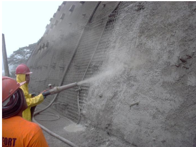
Figura 2.15: Aplicação de concreto projetado (Fonte: Solofort).
