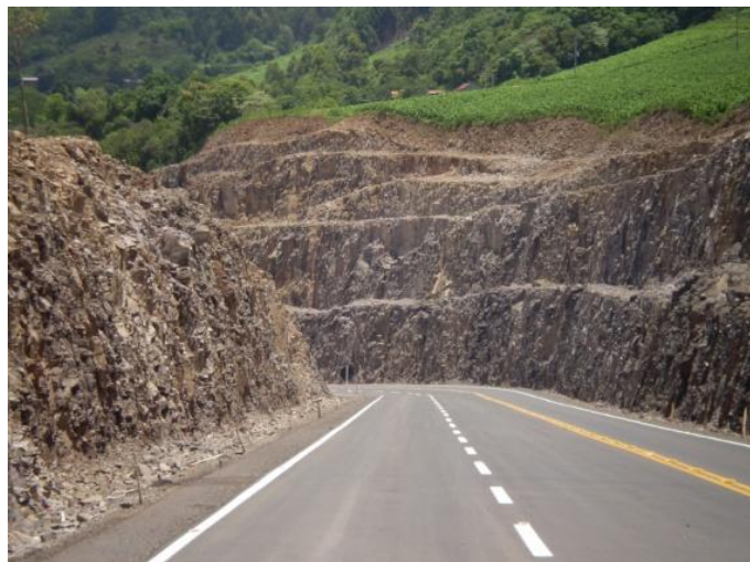
Figura 2.19: Corte rochoso em banquetas.
