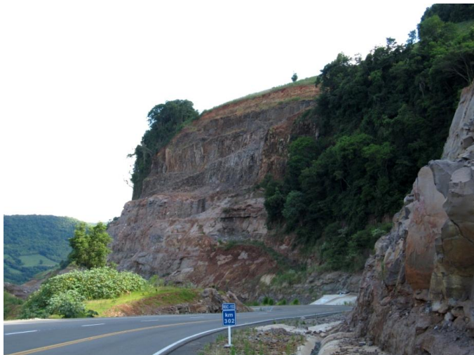
Figura 5.1: Vista geral do talude localizado na estaca 57+800.
