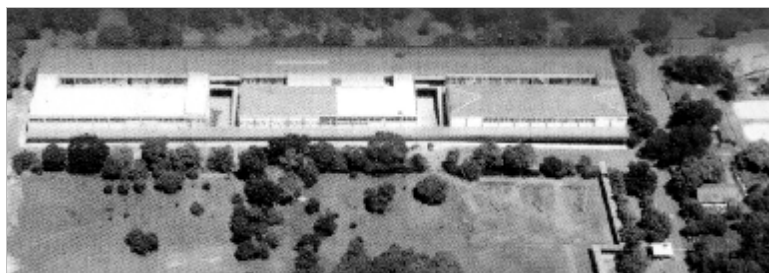
Figura 1 - Fundação Escola Técnica Liberato Salzano Vieira da Cunha.
