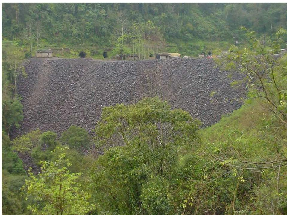
Figura 2.6: Exemplo de depósito de rejeito em encosta. Ao fundo as galerias do Ganzer, Palma (2003.)
